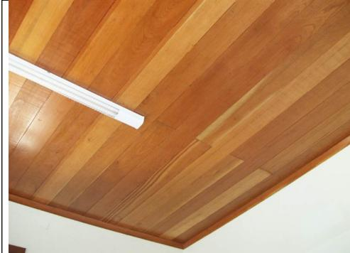
Figura 18 – Forro tabuado liso de madeira
