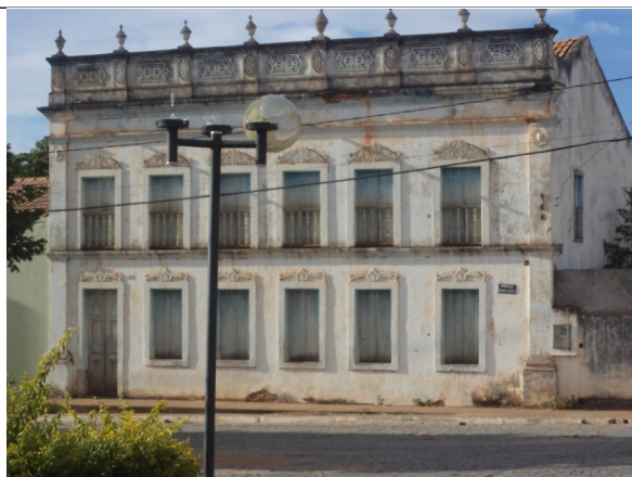
Figura 11 – Acima aspecto atual da edificação inventariada pelo IEPHA na década de 1980 (figura 5). Fonte: Promotoria de Patrimônio Cultural
