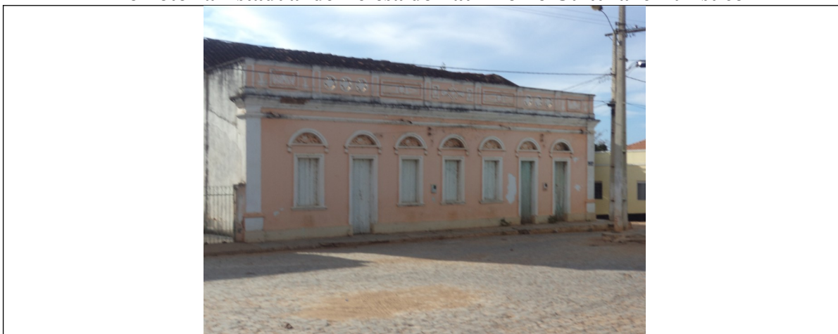
Figura 12 – Acima aspecto atual da edificação inventariada pelo IEPHA na década de 1980 (figura 7). Fonte: Promotoria de Patrimônio Cultural
