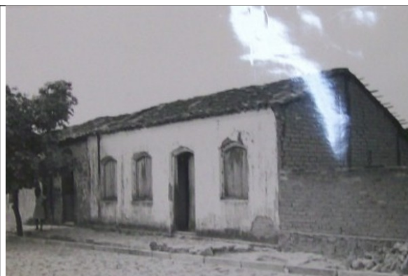
Figura 4 - Edificação localizada no entorno da Praça da Igreja Nossa Senhora da Conceição (Matriz), nº 33.
