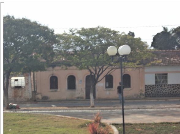
Figura 10 – Acima aspecto atual da edificação inventariada pelo IEPHA na década de 1980 (figura 6). Fonte: Promotoria de Patrimônio Cultural.
