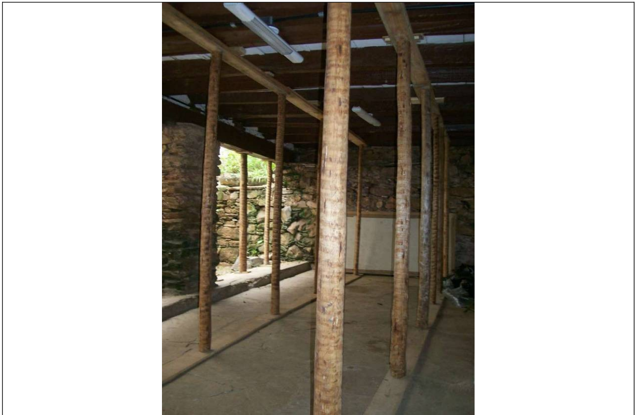
Figura 10 – Esquema para escoramento das peças de madeira do telhado, do piso (através do porão) e das varandas.
