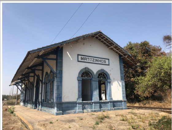
Figura 4 – Fachada lateral direita da Estação Ferroviária de Matozinhos.
