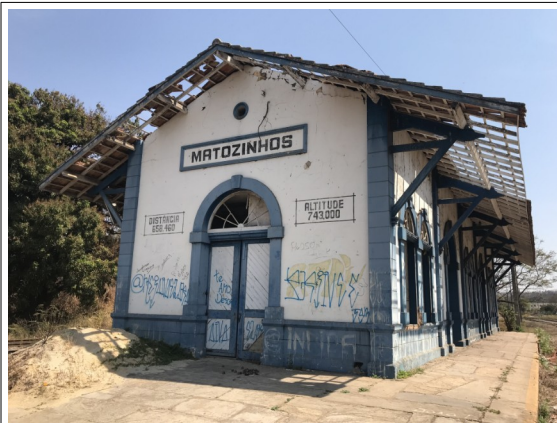
Figura 3 – Fachada lateral esquerda da Estação Ferroviária de Matozinhos.
