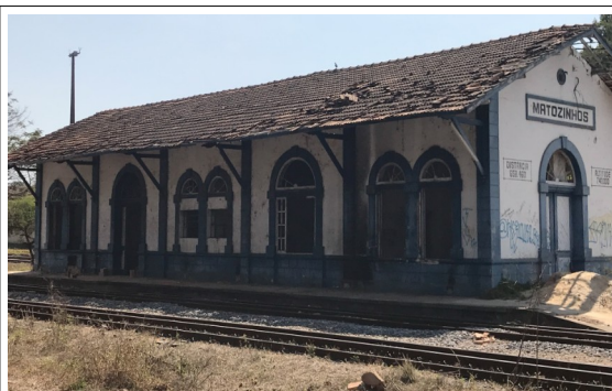
Figura 2 – Fachada posterior da Estação Ferroviária de Matozinhos.
