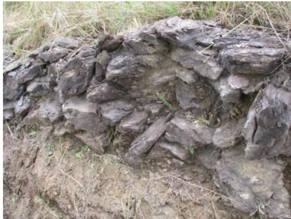
Fotos 6 (esq.) e 7 (dir.) - Detalhes dos muros de divisa de alvenaria de pedra. Município: Ouro Preto, MG. Fotos: Alenice Baeta e Henrique Piló.
