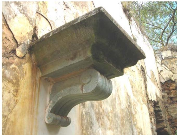
Foto 34 - Detalhe da bacia e console em granito que sobrou do púlpito. 2011. Foto: Guilherme Ataídes.
