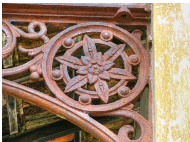
Foto 52 - Estação Ferroviária de Chrockatt de Sá: detalhe da mão francesa em ferro fundido sobre a plataforma. Foto: Henrique Piló, 2012.
