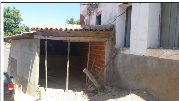
Figura 28 – Vista da intervenção.
