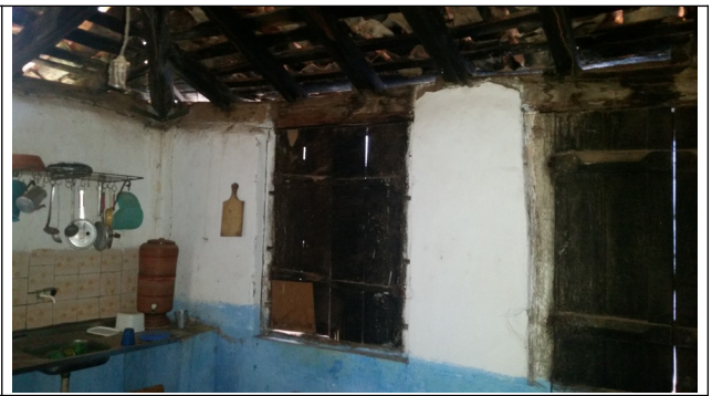
Figura 13 – Imagem interna da edificação.
