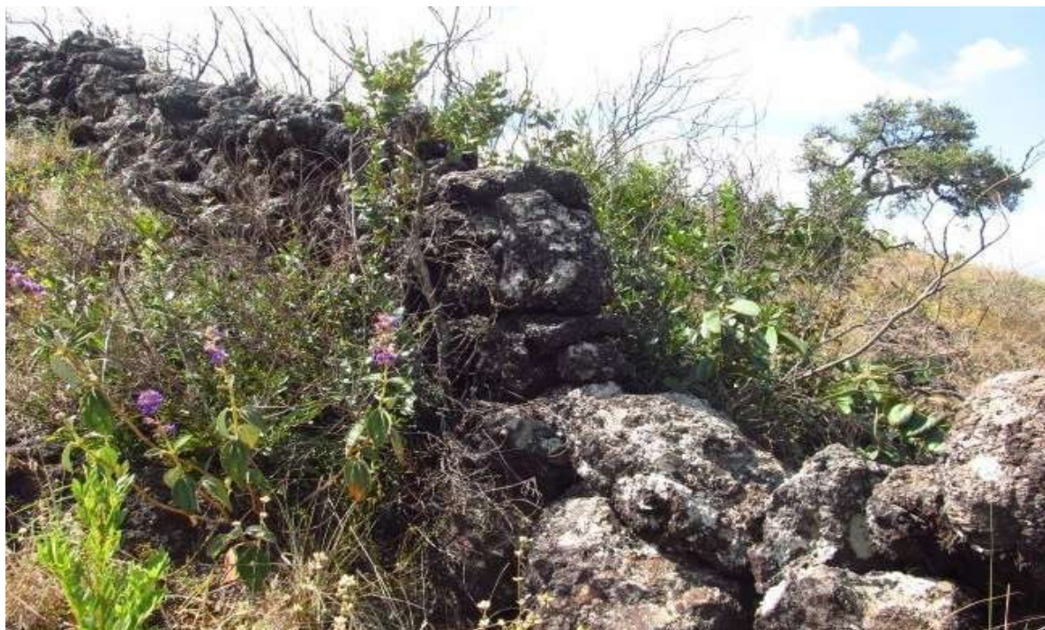
Os muros de pedra podem ser remanescentes do antigo arraial de Curral Del Rei, origem do município de Belo Horizonte
