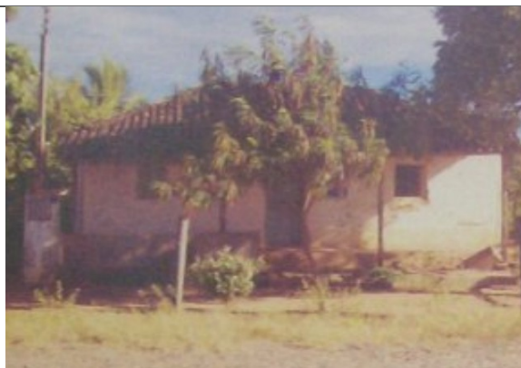
Figura 14 - Casa edificada na principal rua do povoado de Panelinha II – área 3. Fonte: Prefeitura de Miravânia.
