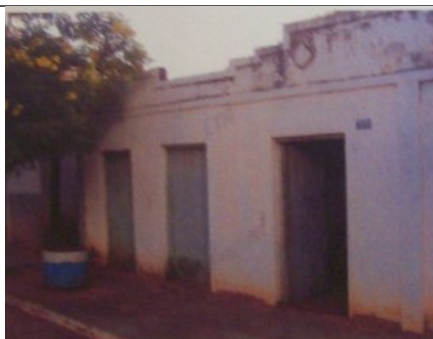
Figura 7 – Casa edificada na Rua Novo Oriente, n° 100. área 1 Fonte: Prefeitura de Miravânia
