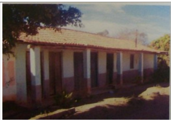
Figura 13 – Casa edificada na principal rua de Panelinha I – área 3. Fonte: Prefeitura de Miravânia.
