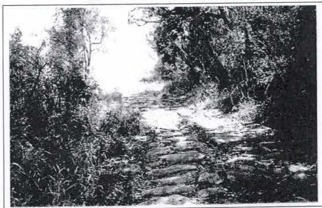
Figura 34: Calçadão secundário à Estrada Real – Moeda Velha
