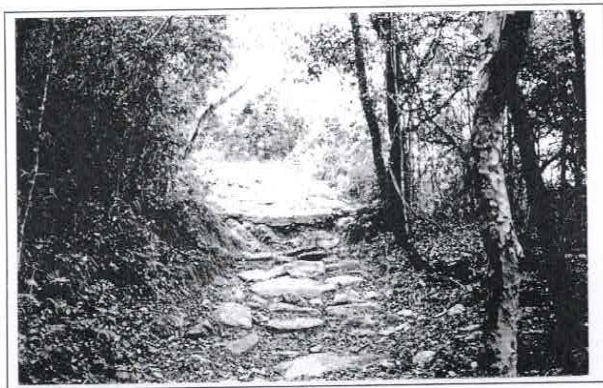
Figura 37: Calçadão secundário à Estrada Real – Moeda Velha
