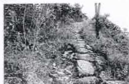
Foto 051– Calçadão de Pedras – trecho com deslizamento;
