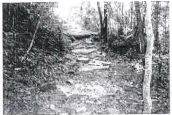
Foto 053- Calçadão de Pedras – deslizamento do calçamento;
