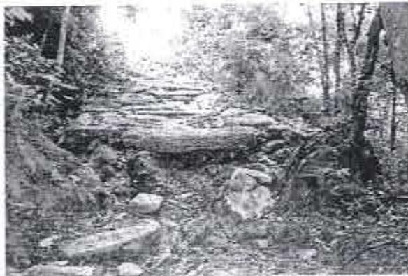
Foto 052- Calçadão de Pedras – deslizamento do calçamento;
