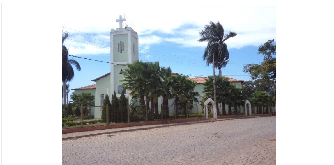
Figura 04- Igreja em Montalvânia. Fonte: Promotoria Estadual de Defesa do Patrimônio Cultural e Turístico de Minas Gerais.
