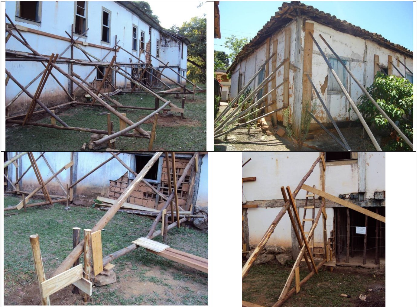
Figuras 04 a 07 – Escoramento de alvenarias.
