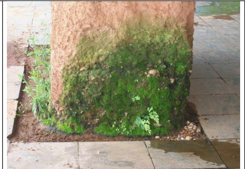
Figuras 5 e 6 - Formação de bolor e o aparecimento de musgos nas estruturas de concreto e em outros integrantes do monumento.
