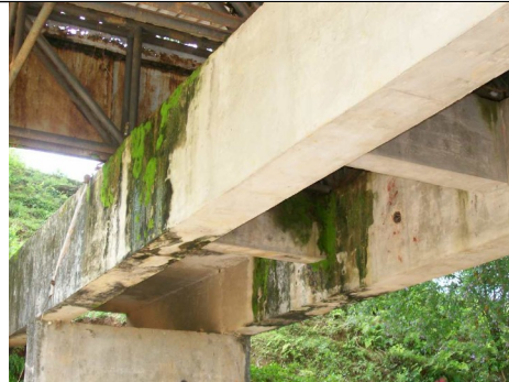
Figuras 5 e 6 - Formação de bolor e o aparecimento de musgos nas estruturas de concreto e em outros integrantes do monumento.
