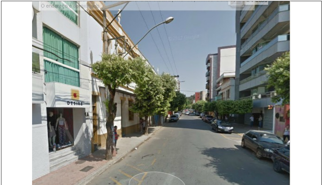
Figura 03 – Panorama da rua onde está localizada a edificação. Edificação em tela à esquerda da imagem. Verifica-se a forte tendência de verticalização da área. Fonte: Google street view
