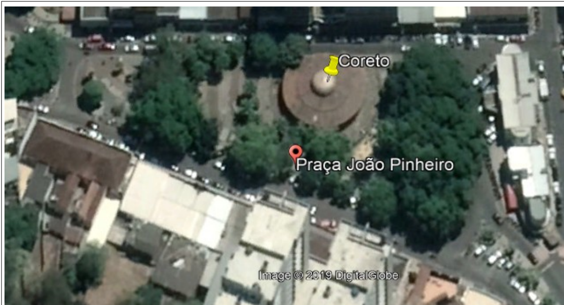
Figura 11 - Imagem aérea com a localização do Conjunto Arquitetônico e Paisagístico da Praça João Pinheiro em Muriaé. O coreto foi indicado de amarelo e ocupa uma grande área no conjunto urbano tombado da Praça João Pinheiro. Fonte: GOOGLEEARTH, 2019. Data da imagem: 12/10/2018.
