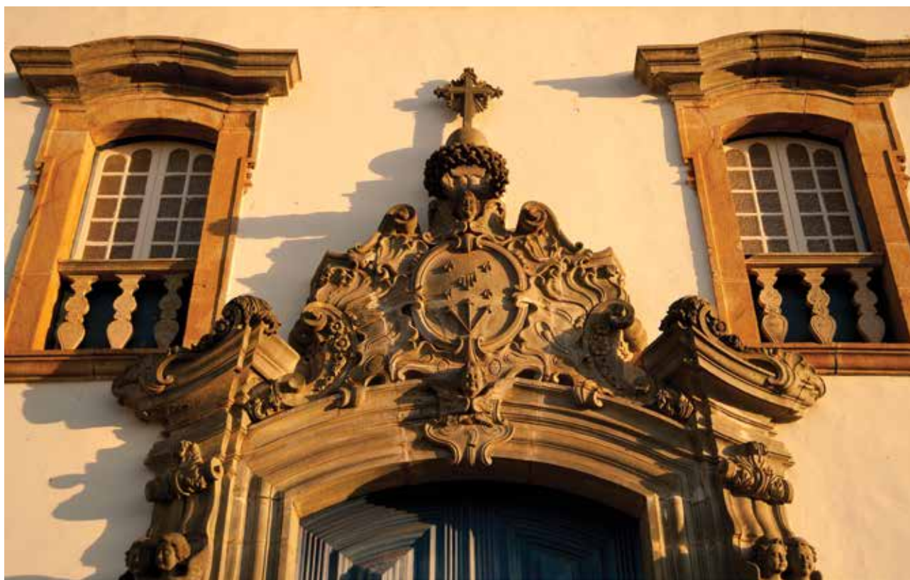
Trabalhos em pedra na portada da Igreja do Bom Jesus do Matosinhos de Congonhas. Fotografia: Miguel Aun
