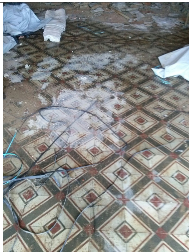
Figura 08 – Imagem do piso em ladrilhos hidráulicos da igreja que ainda se encontra preservado, em bom estado de conservação.
