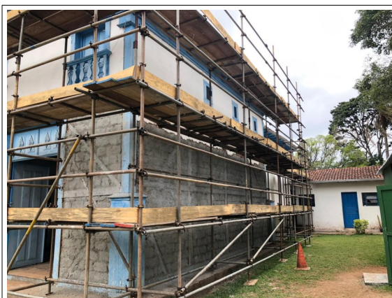
Figura 01 - Imagem integrante da certidão, com emboço e reboco em fase de execução.
