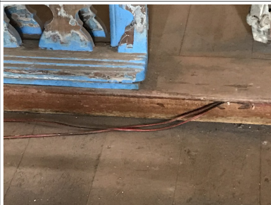
Figura 09 - Fiação aparente.
