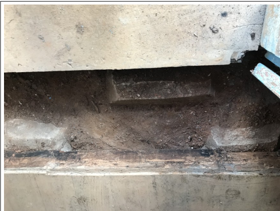
Figura 07 - Tabuas removidas no piso.
