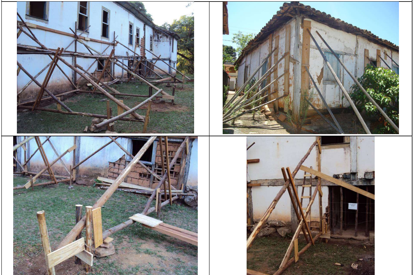
Figuras 04 a 07 – Escoramento de alvenarias.
