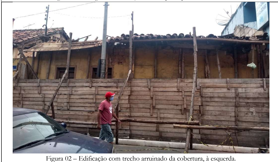
Figura 01 – Imagem da edificação vedada por tapumes e escorada.
