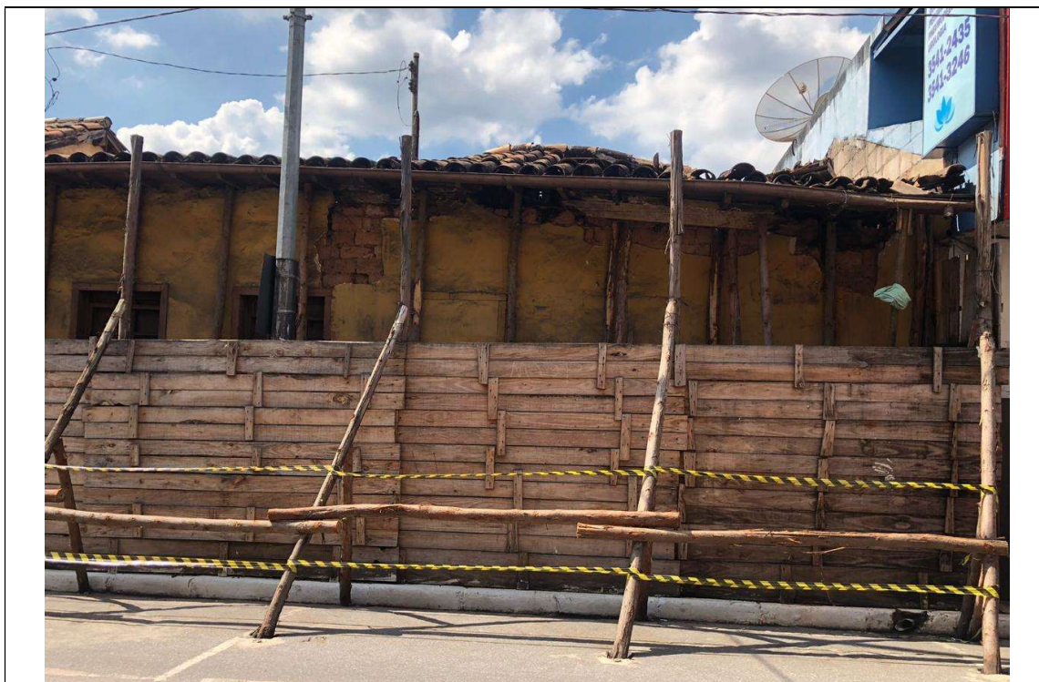
Figura 01 – Imagem da edificação vedada por tapumes e escorada.
