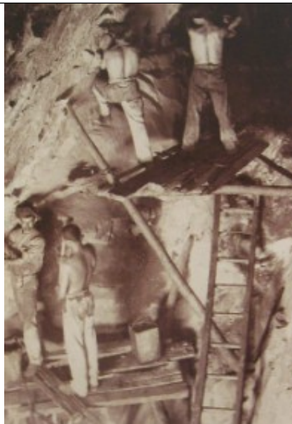
Figura 06- Perfuração manual da Mina de Morro Velho. Fonte: RODRIGUES, Victor. Nova Lima dos Ingleses: a história do pioneiro George Chalmers. Belo Horizonte: É Editora, 2012.
