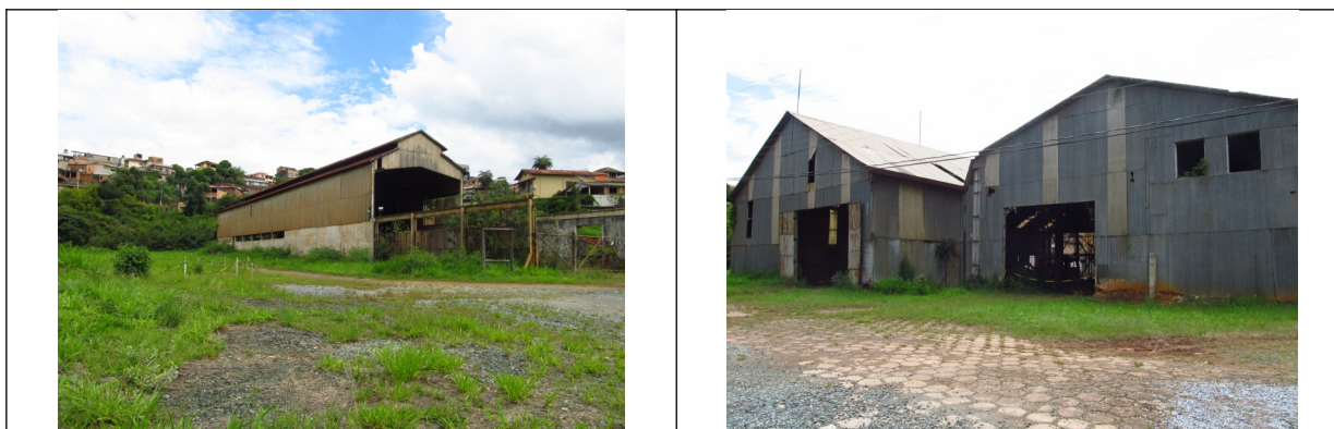
Figuras 36 e 37- Prédios da Fundição de Ferro e Bronze e da Oficina Mecânica, integrantes do antigo complexo de Morro Velho. Fotos da vistoria.
