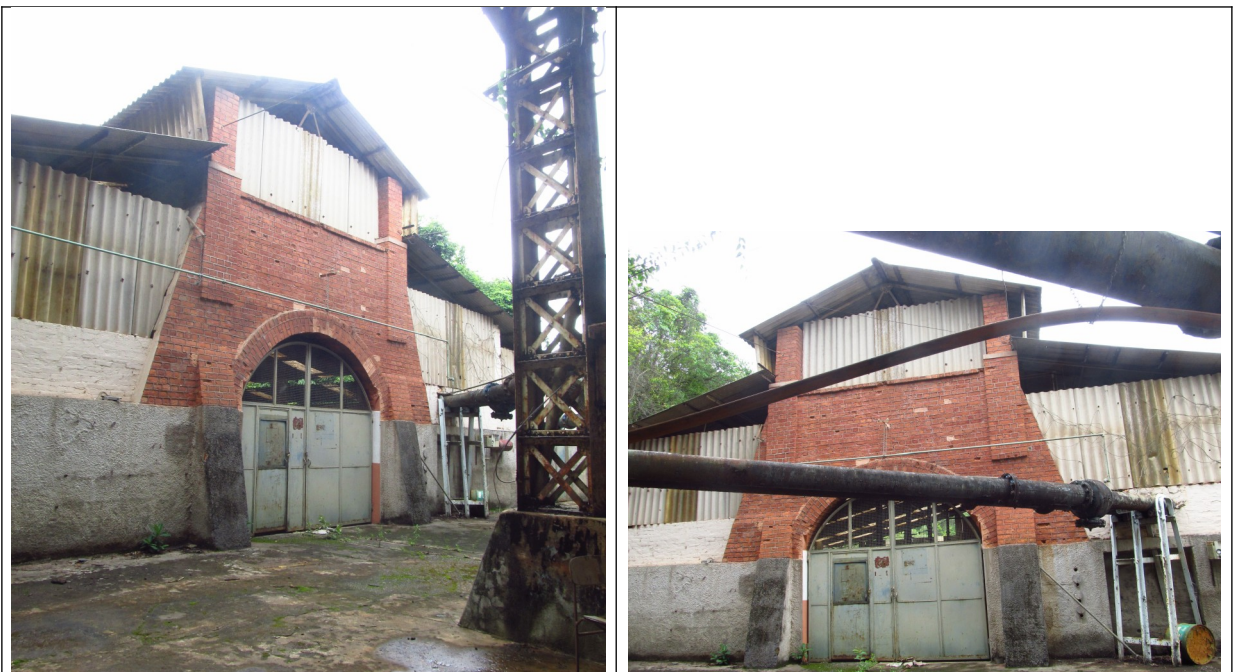
Figuras 40 e 41- Almojarifado da Mina Grande no antigo complexo de Morro Velho. Fotos da vistoria.
