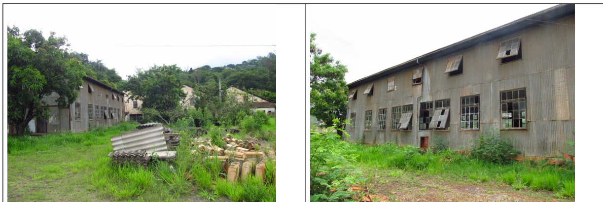
Figuras 22 e 23- Casa dos Moldes, integrante do antigo complexo de Morro Velho. Fotos da vistoria.
