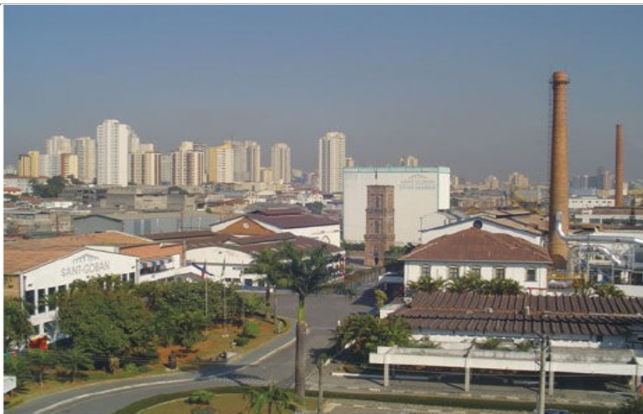
FIGURA 06 - Conjunto das edificações da Saint - Gobain, antiga Vidraria Santa Marina. Remanescentes tombados: Torre de energia; duas chaminés (fornos 5 e 20) e dois edifícios (Amazonas e São Paulo). Resolução de Tombamento 05/09. Fotografia: Angela Rösch Rodrigues, 2008.
