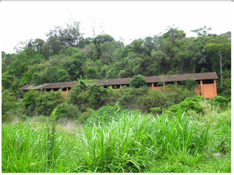
Figura 12 – Prédio da carvoaria tomado pela vegetação.
