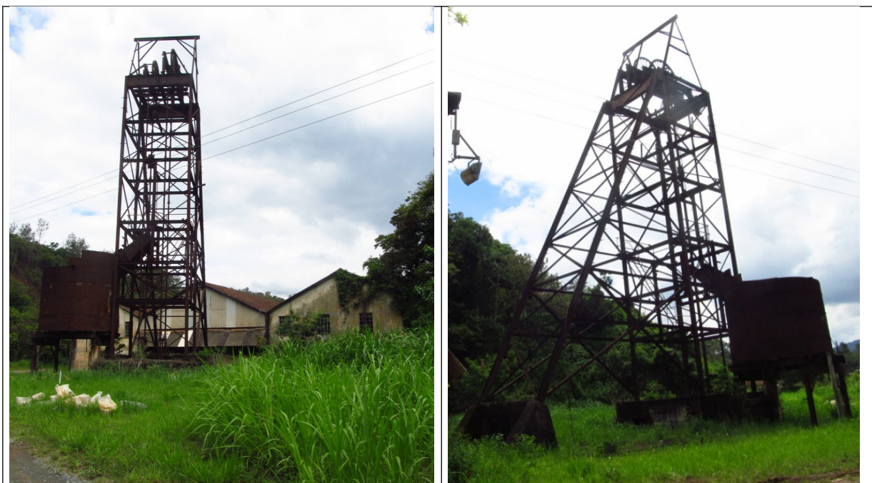
Figuras 42 e 43- Torre de shaft, no antigo complexo de Morro Velho. Fotos da vistoria.
