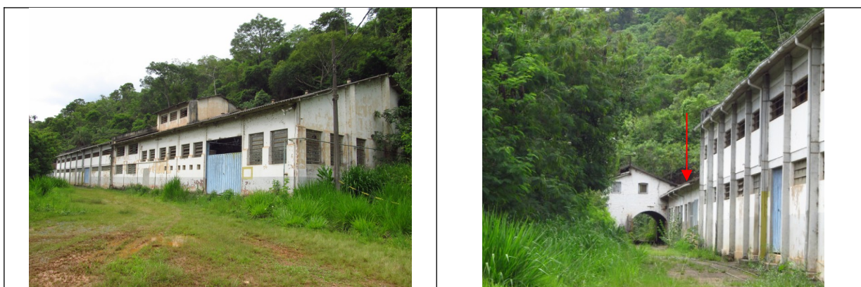
Figuras 34 e 35- Vestiários e Refeitório (assinalado com seta vermelha), integrantes do antigo complexo de Morro Velho. Fotos da vistoria.
