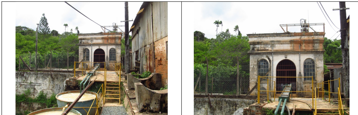
Figuras 32 e 33- Casa de Força, integrante do antigo complexo de Morro Velho. Fotos da vistoria.
