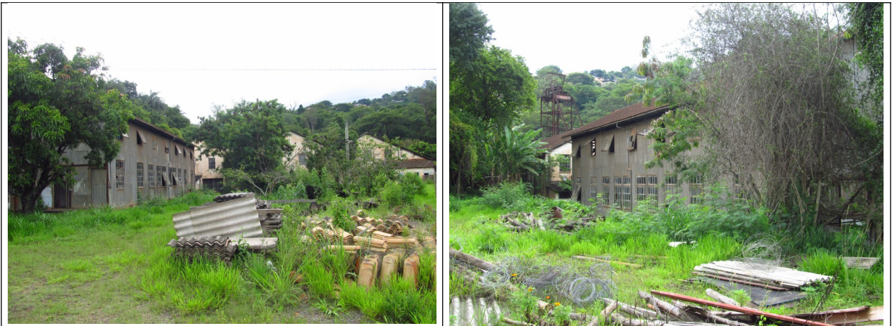
Figuras 13 e 14 - Material de construção e entulhos dispersos pelo terreno.
