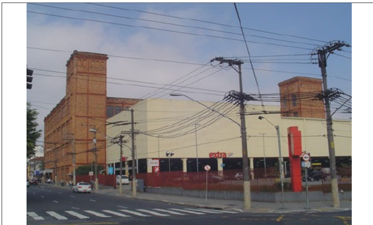
Figura 44- Parte das instalações do Cotonifício Crespi, transformado em hipermercado. Fonte: http://www.revistas.usp.br/cpc/article/viewFile/15664/17238 . Acesso em 05-12-2014.
