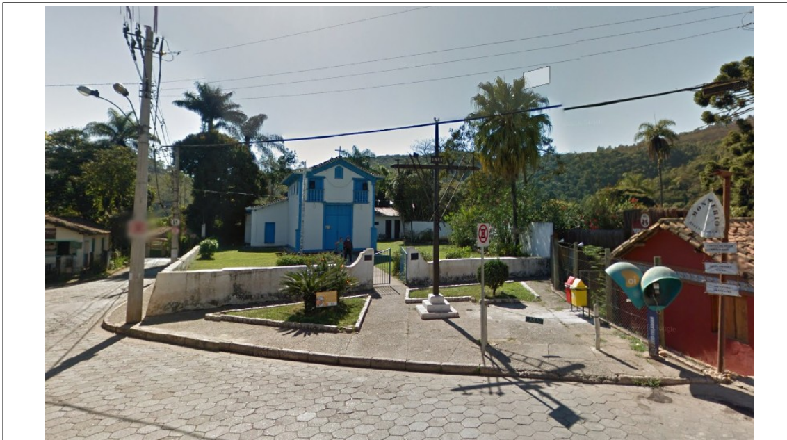
Figura 2 - Capela de São Sebastião das Águas Claras. Fonte: Google Street View-julho 2013.
