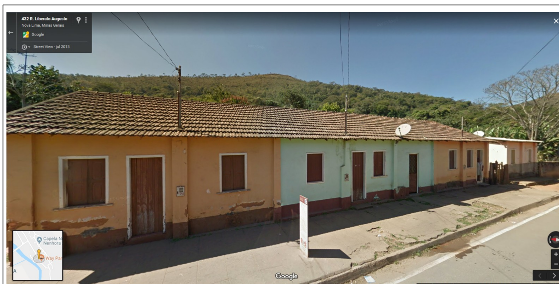
Figura 1- Conjunto de bonserás na Rua Liberato Augusto em Honório Bicalho. Fonte: Google Street View.
