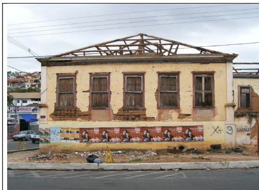
Figura 18 – Imagem externa do imóvel.
