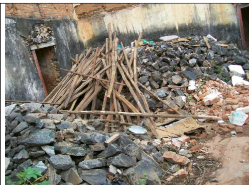
Figura 20 – Material estocado no terreno do imóvel.
