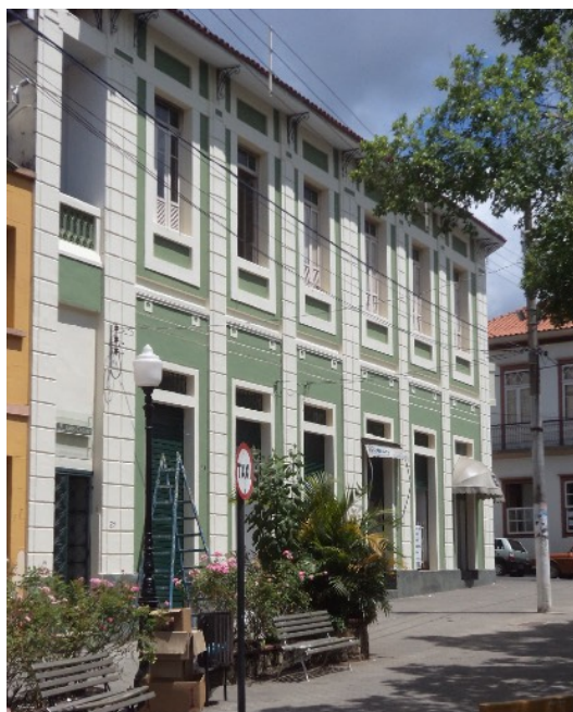
Figura 9 – Sobrado no entorno da Praça, estilo neo colonial..
