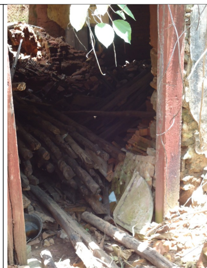
Figura 13 – Material estocado no porão em 03/02/2012.
