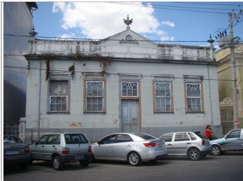
Figura 06 – Fachada frontal da edificação.
