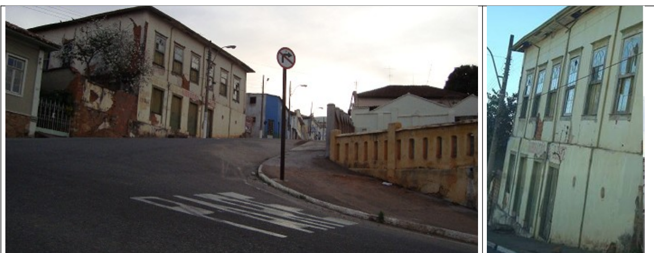
Figuras 04 e 05 – Fachadas do imóvel.
