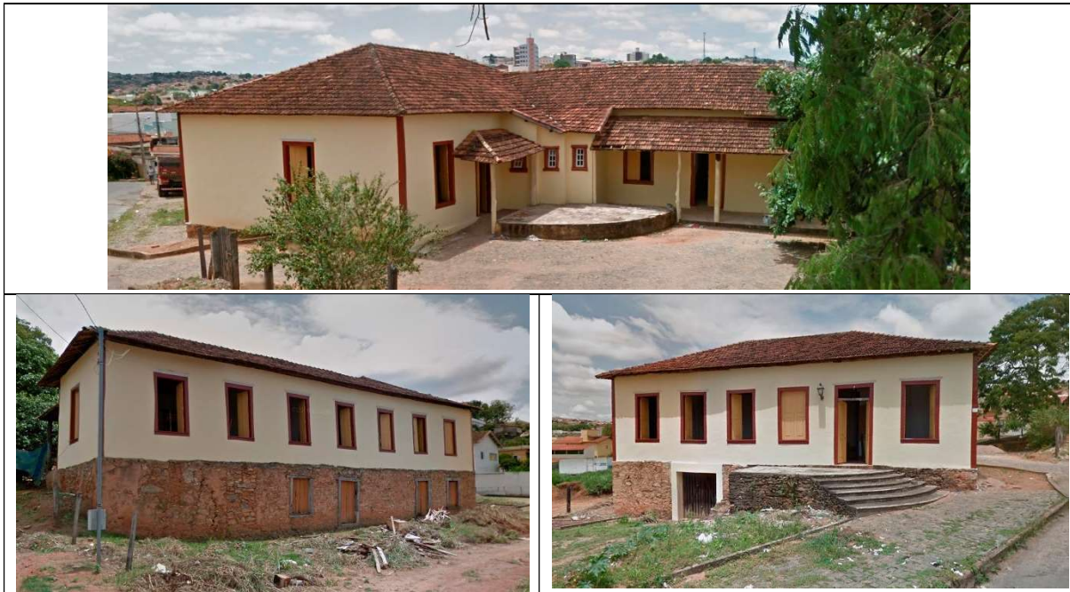
Figuras 06 a 08 – Casarão do Onofre, situado na R. Primeiro de Janeiro n° 220, durante as obras. Fonte: Google Street View. Novembro de 2015.
