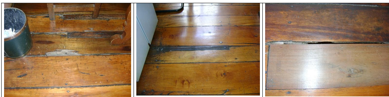
Figuras 24, 25 e 26 – Piso de madeira danificado.
