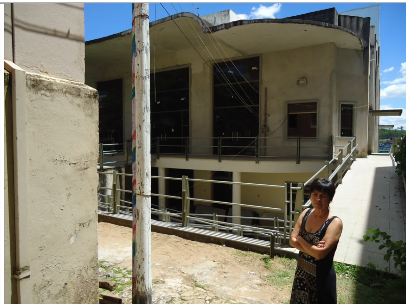
Figura 31 – Construção nos fundos do terreno.
