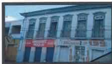
Antigo Hotel Colonial em estado de abandono
