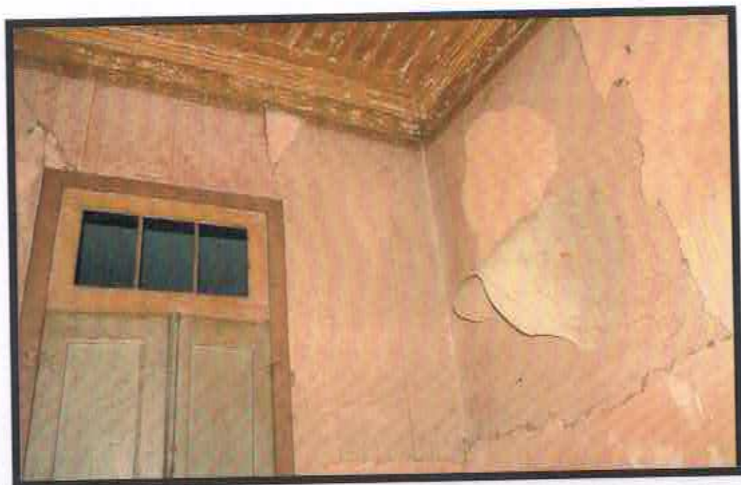
Quarto com fragmentos de papel de parede e ambientes com pinturas em moldes ou estêncil.
