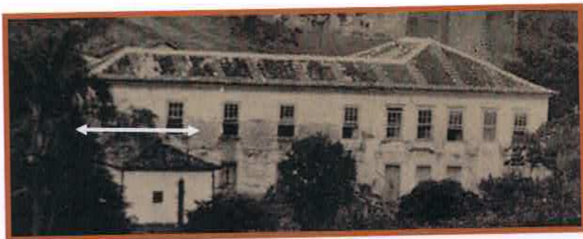
- Imagem produzida na década de 1920. Área indicada pela seta corresponde a parte demolida há décadas, restando apenas a base de pedras do primeiro pavimento. Acervo do autor. -
