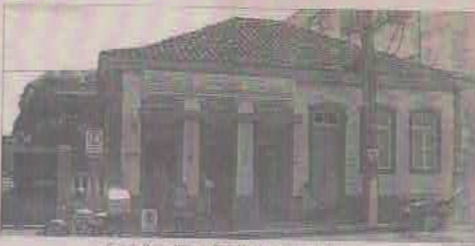
Casa do Doutor Hilário, na Praça XV, já em estado de demolição.
