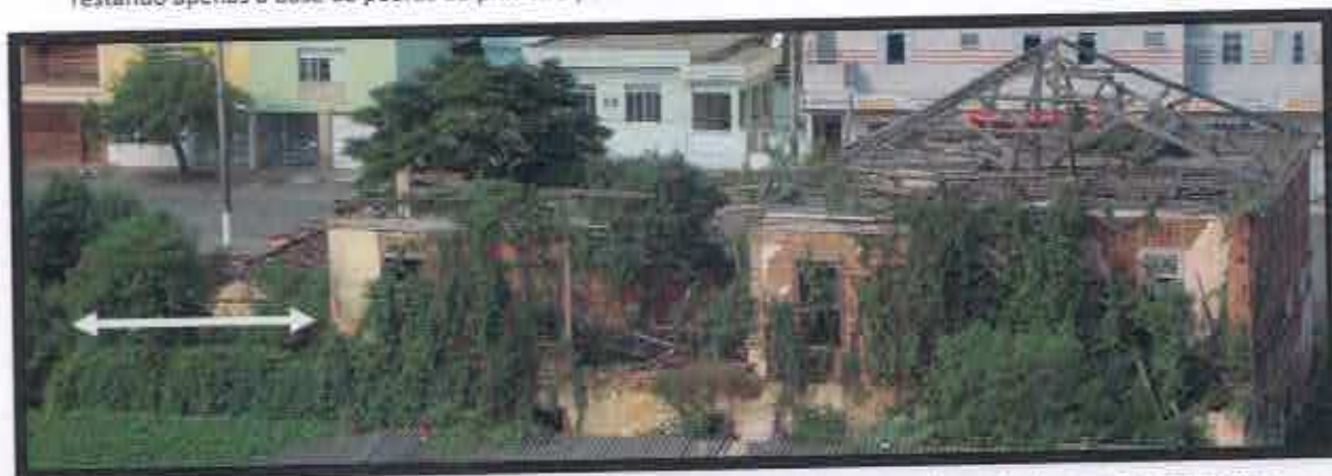
Observar nessa imagem que parte da alvenaria de pedras encobertas pela vegetação ao fundo corresponde à área do piso superior desaparecida em época incerta. O sobrado contava com uma área construída ainda maior.
