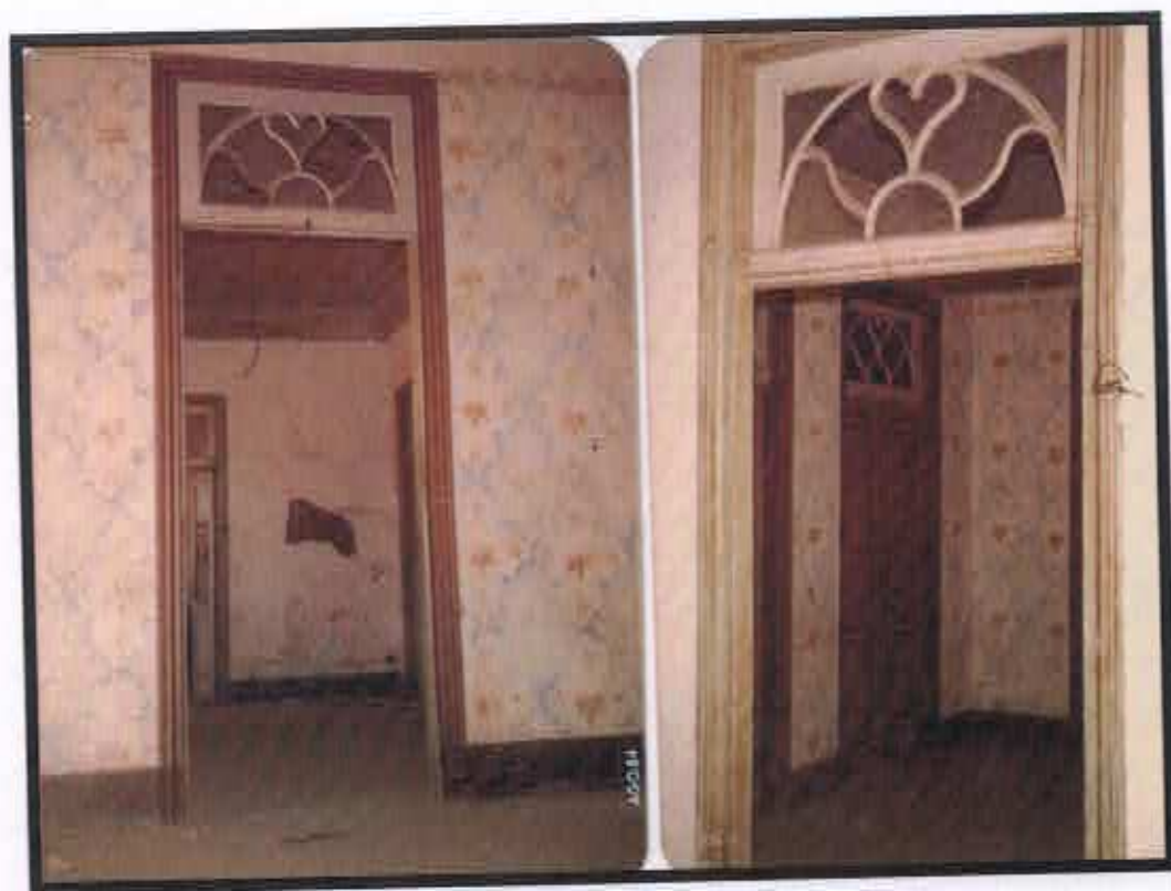
-Imagens dos interiores do sobrado em 2006 e em 1984-
