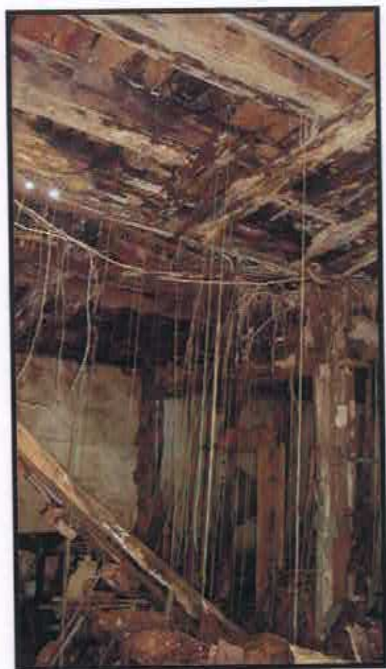
- Estrutura dos barrotes que sustentavam o piso das salas frontais. 07/06/2013
