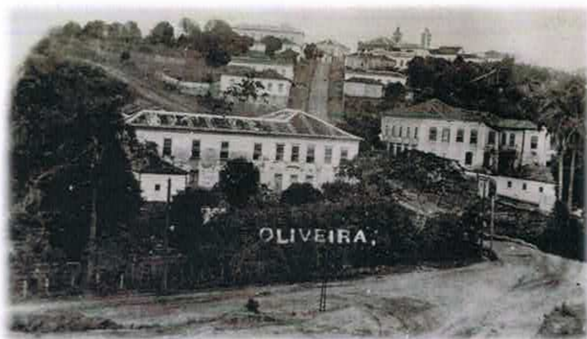
Sobrado da Figuiinha – edificação à esquerda, em primeiro plano.
