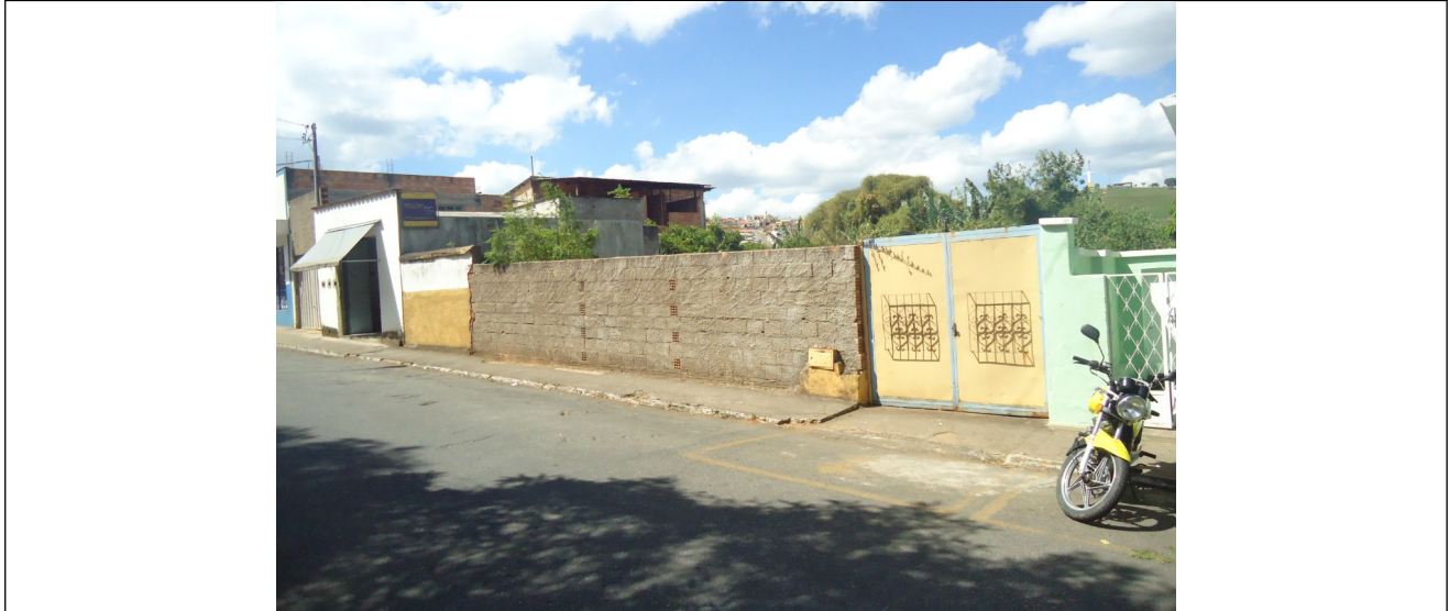
Figura 04 – Imagem atual do imóvel localizado na Praça José Triunfo Lobato nº 28.
