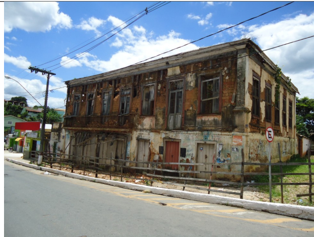
Figura 04 - Casarão da Figuiinha (imagem de 2012) recentemente demolido em Oliveira. Fonte: Acervo da CPPC.
