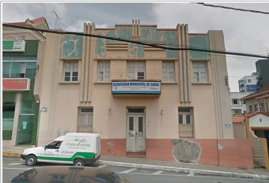
Figura 2 – Imóvel da Praça Dr. José Ribeiro da Silva, nº 16, em dezembro de 2015. Fonte: Google Street View 2019.
