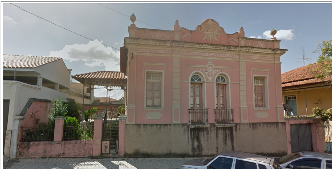
Figura 2 – Imóvel da Av. Pinheiro Chagas, nº 156, em novembro de 2018. Fonte: Google Street View 2019.
