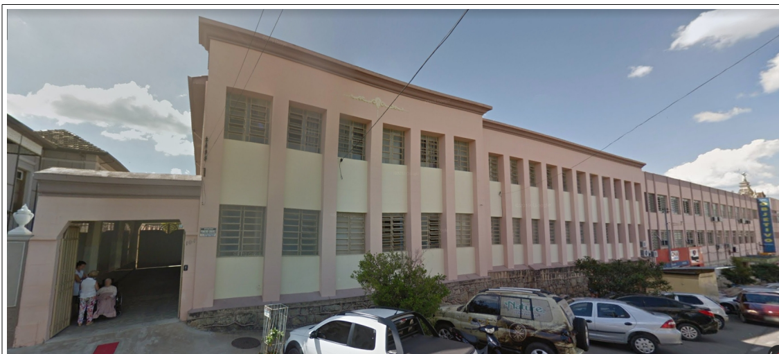
Figura 2 – Imóvel da Av. Pinheiro Chagas, nº 22/26/30/104, em novembro de 2018. Fonte: Google Street View 2019.
