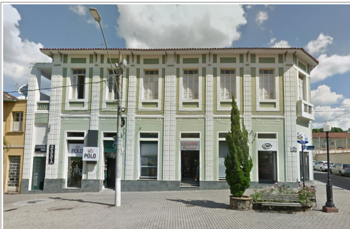
Figura 2 – Imóvel da Praça XV de Novembro, nº 118/120/126/130, em novembro de 2018. Fonte: Google Street View 2019.
