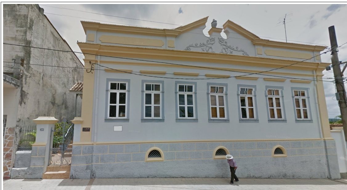
Figura 2 – Imóvel da Praça Dr. Domingos Ribeiro, nº 199, em novembro de 2015. Fonte: Google Street View 2019.
