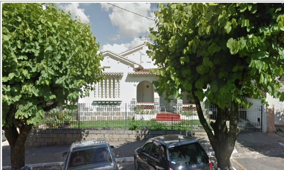
Figura 2 – Imóvel da Av. Pinheiro Chagas, nº 83, em novembro de 2018. Fonte: Google Street View 2019.
