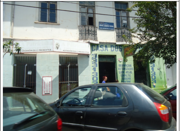
Figura 06 – Pintura na alvenaria que descaracteriza a edificação histórica.
