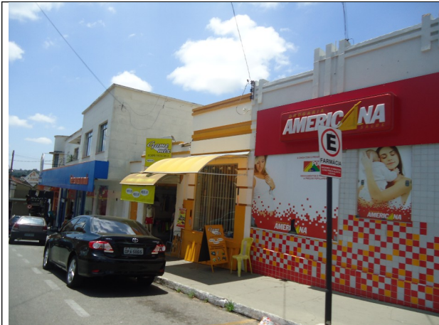
Figura 03 – Fachada de edificação toda ocupada por engenho publicitário e toldos na edificação lateral.
