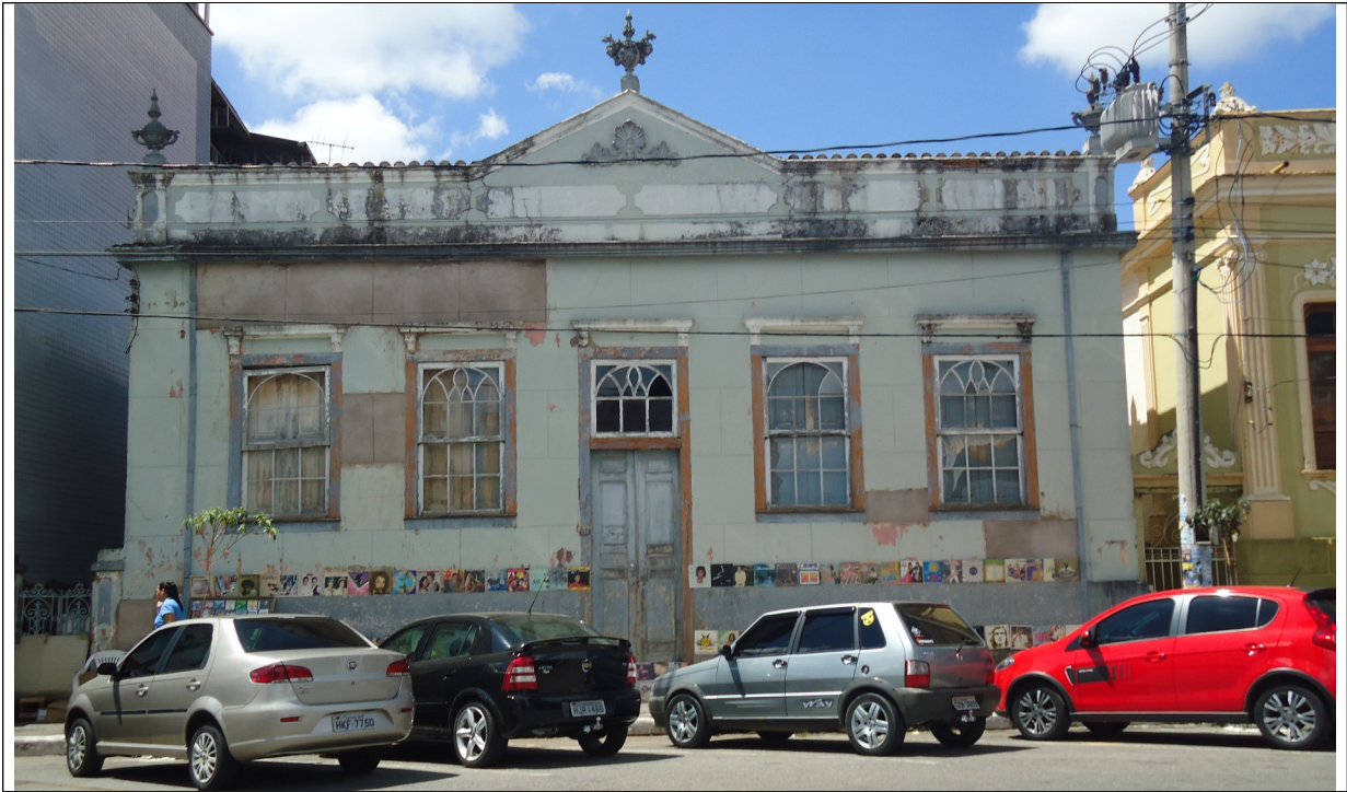
Figura 02 – Imagem atual da edificação.
