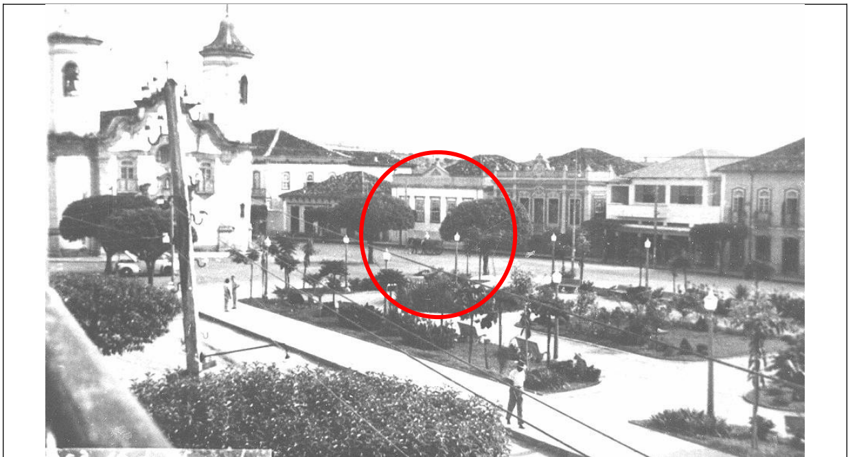
Figura 01 – Imagem antiga da Praça XV de Novembro. Em destaque, a edificação em análise.
