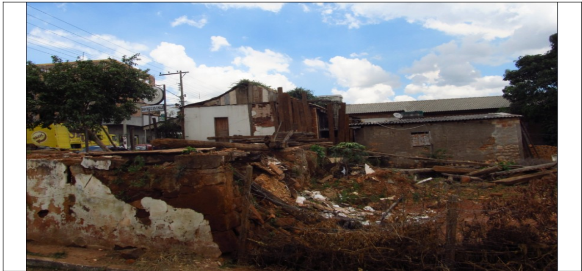
Figura 09 – Terreno da Rua Santo Antônio onde ficava o imóvel demolido. Foto da vistoria.
