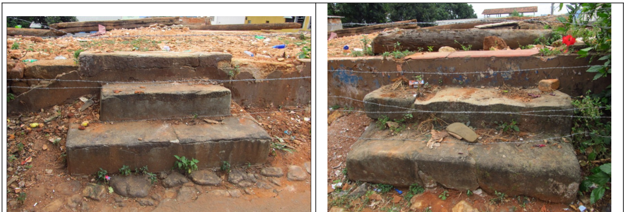
Figuras 10 e 11 – Degraus que davam acesso ao imóvel demolido da Rua Santo Antônio, nº 220. Foto da vistoria.
