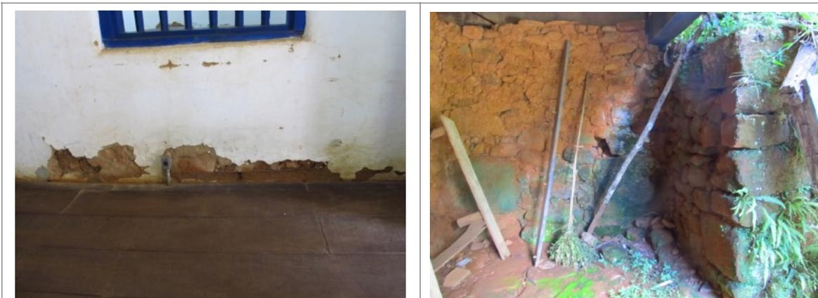
Figuras 24, 25, 26 e 27 – Trincas, descolamento do reboco e manchas de umidade nas alvenarias da Fazenda Carreiras. Foto da vistoria.
