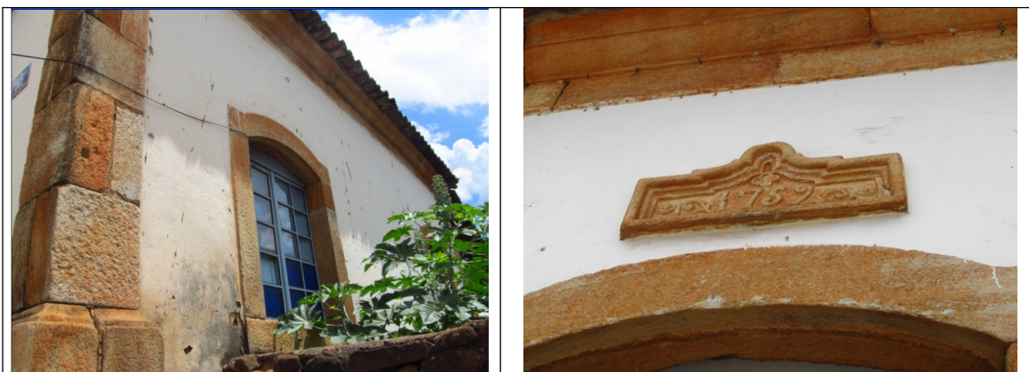
Figuras 10 e 11 – Detalhes das fachadas da Antiga Casa Paroquial em Ouro Branco. Foto da vistoria.
