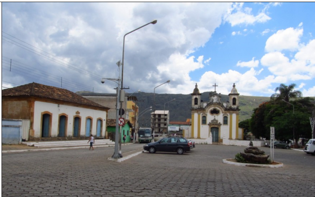
Figura 09 – Casa Paroquial e Igreja Matriz de Santo Antônio em Ouro Branco. Foto da vistoria.
