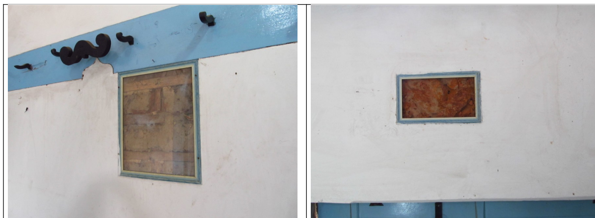
Figuras 12 e 13 – Janelas existentes na edificação que permitem a identificação do sistema construtivo existente.
