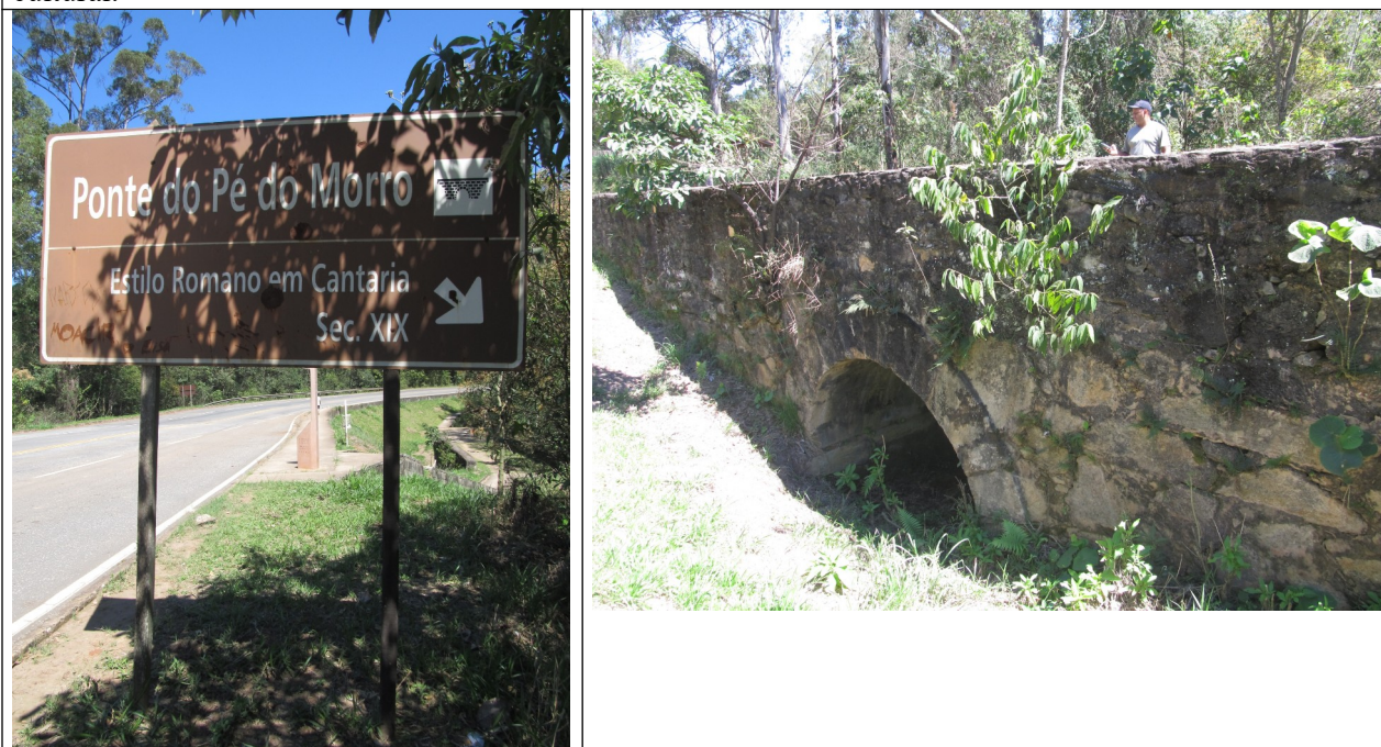
Figuras 06 e 07 – Sinalização indicativa da Ponte do Pé do Morro e detalhe da estrutura na 2ª imagem.
