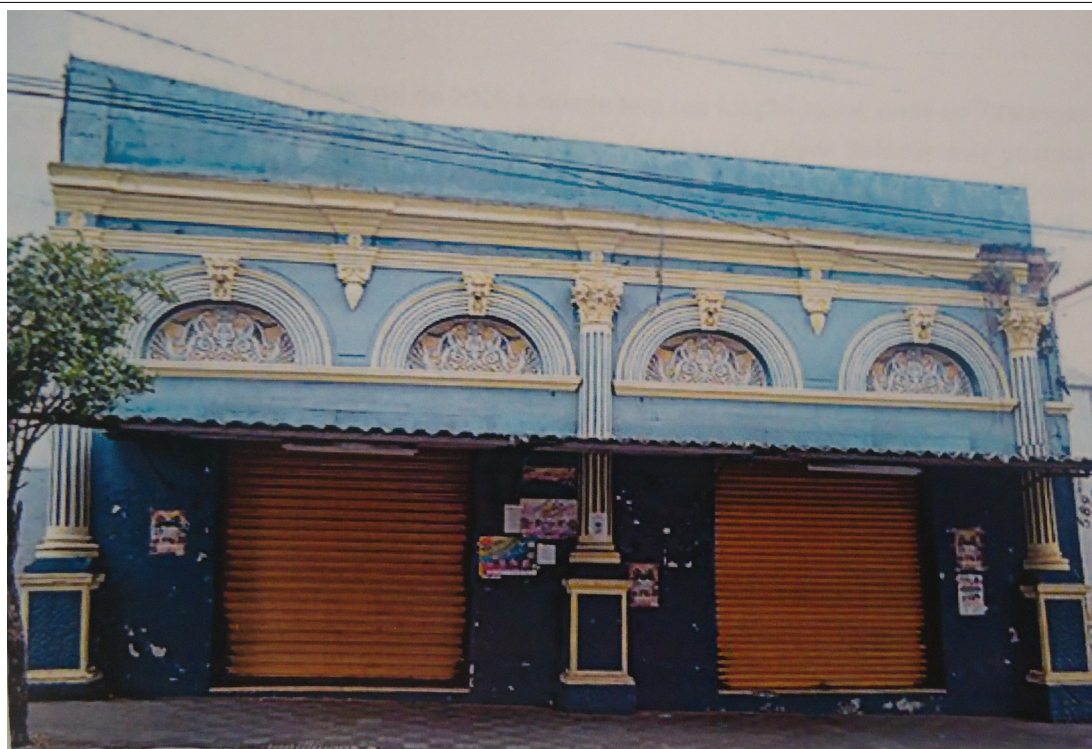
Figura 02 - Fachada do imóvel em 2014
