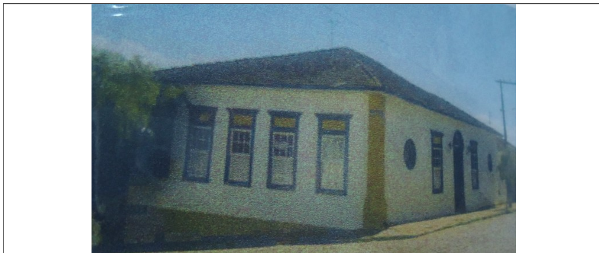
Figura 03 – A edificação no ano de 2000. Fonte : Ficha de inventário do imóvel.
