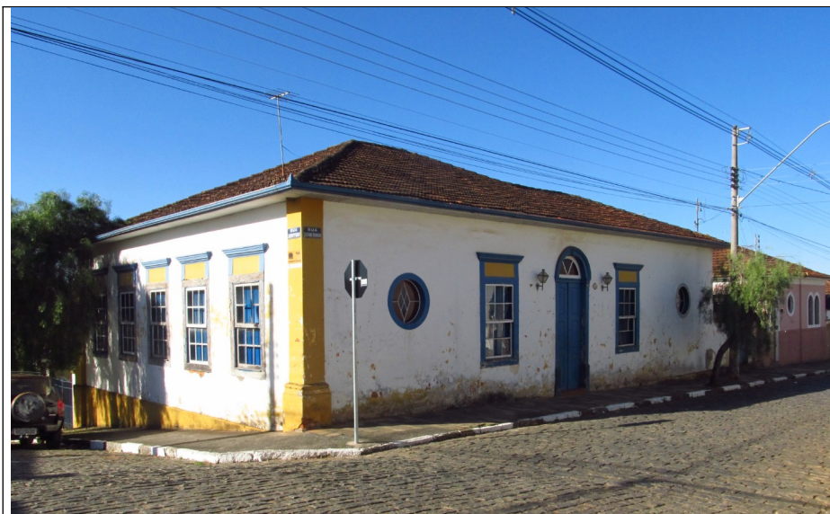
Figura 04 – Imagem atual da edificação.
