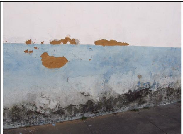
Figuras 12 e 13 – Manchas de umidade e descolamento do reboco e pintura.
