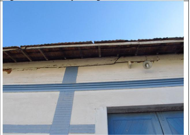
Figura 09 – Trinca na alvenaria, que se encontra instável.
