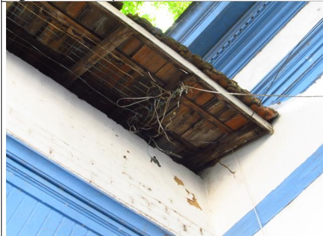
Figura 08 – Instalações elétricas precárias.
