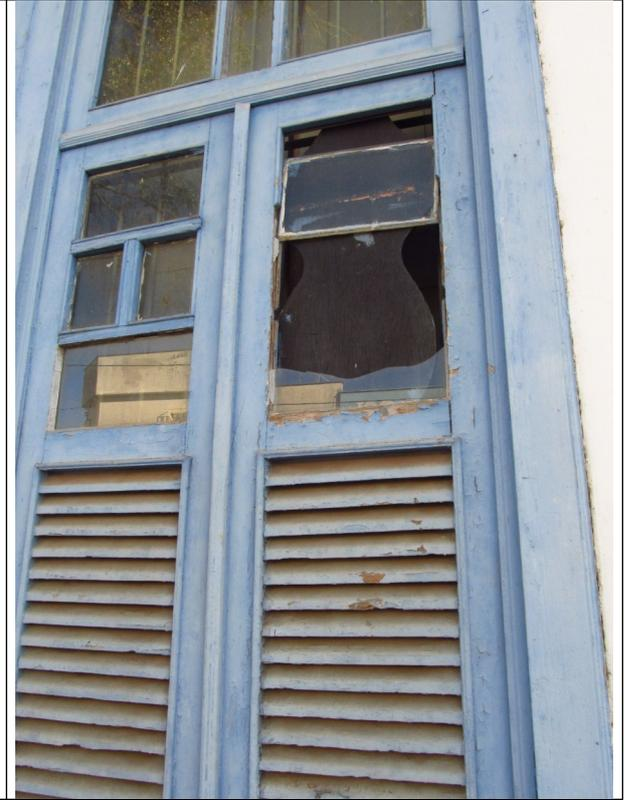
Figura 11 – Vidros quebrados nas janelas.
