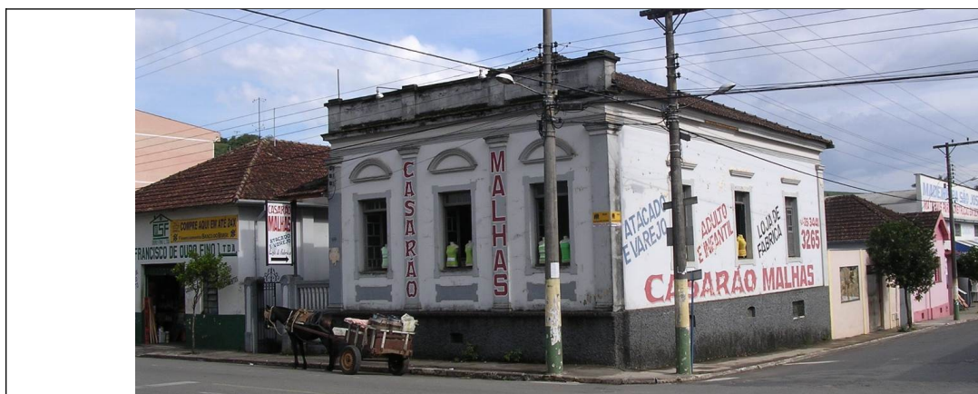
Figura 09 – Casarão das malhas, demolido recentemente.
