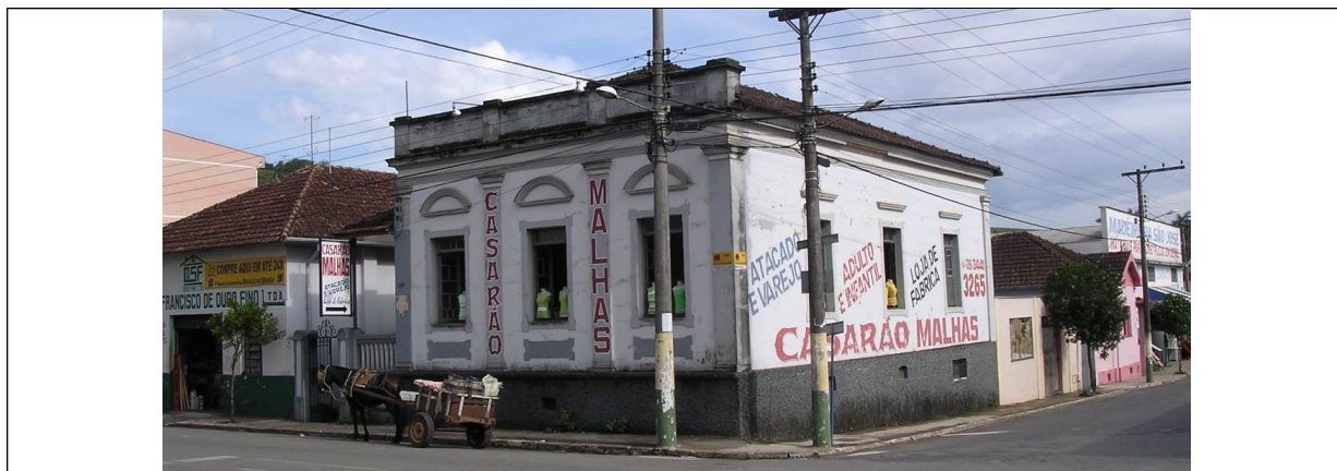
Figura 06 – Casarão das malhas, demolido recentemente.
