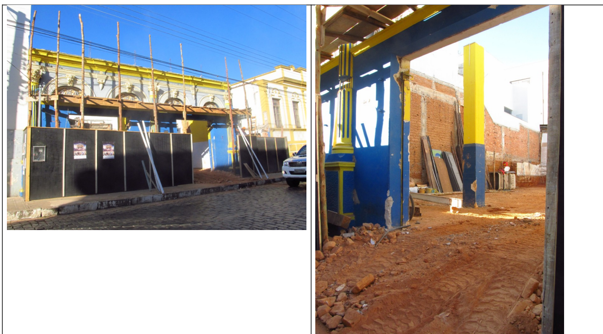
Figuras 05 e 06 – Situação do imóvel na data da vistoria.
