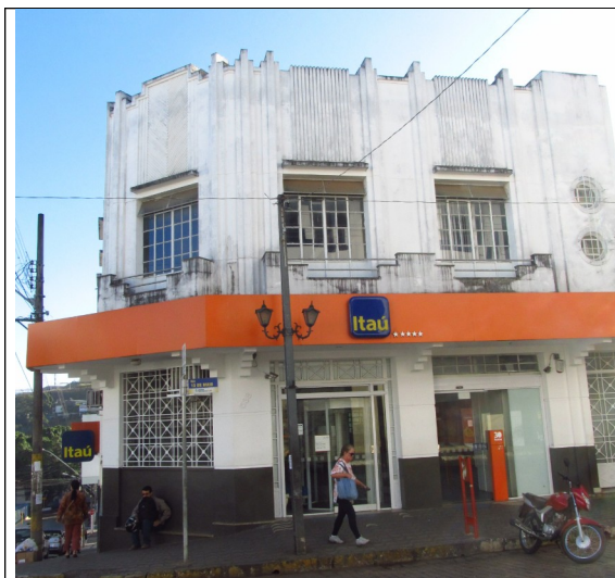
Figura 10 – Edificação de nº 538.
