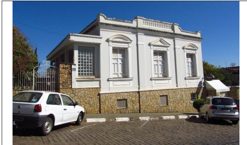
Figura 61 – Fachada frontal do imóvel.
