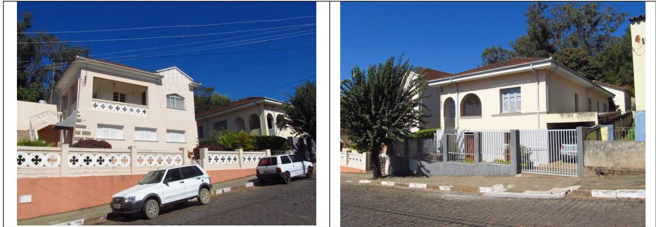
Figuras 72 e 73– Fachadas frontais dos imóveis.
