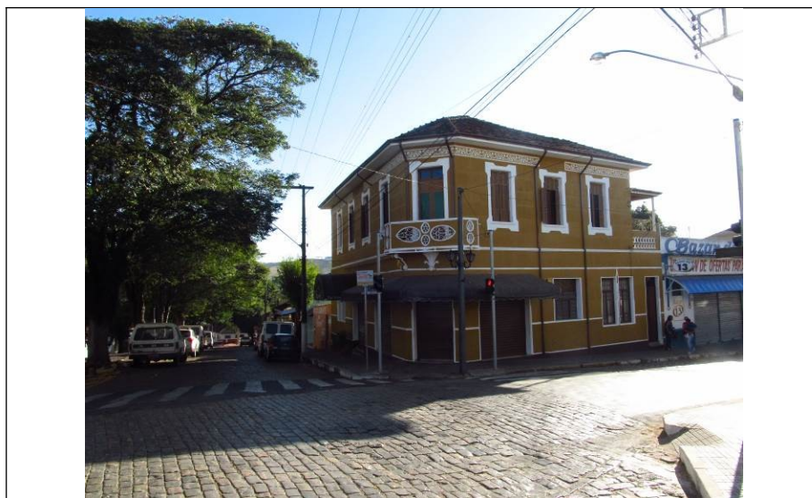
Figura 32 – Fachada frontal do imóvel.
