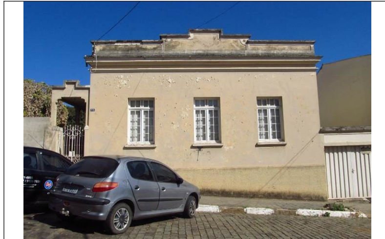
Figura 57 – Fachada frontal do imóvel.
