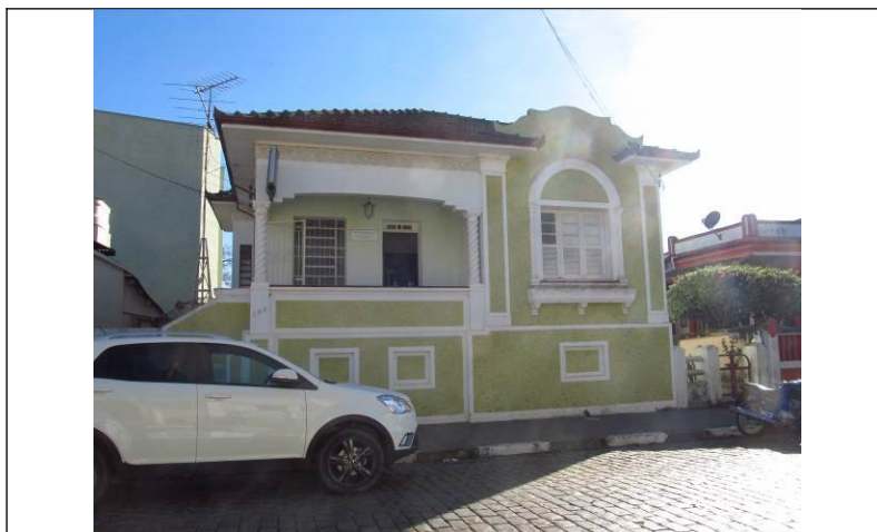
Figura 39 – Fachada frontal do imóvel.
