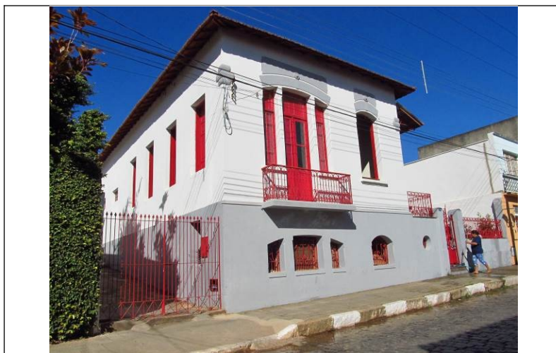
Figura 47 – Fachada frontal do imóvel.
