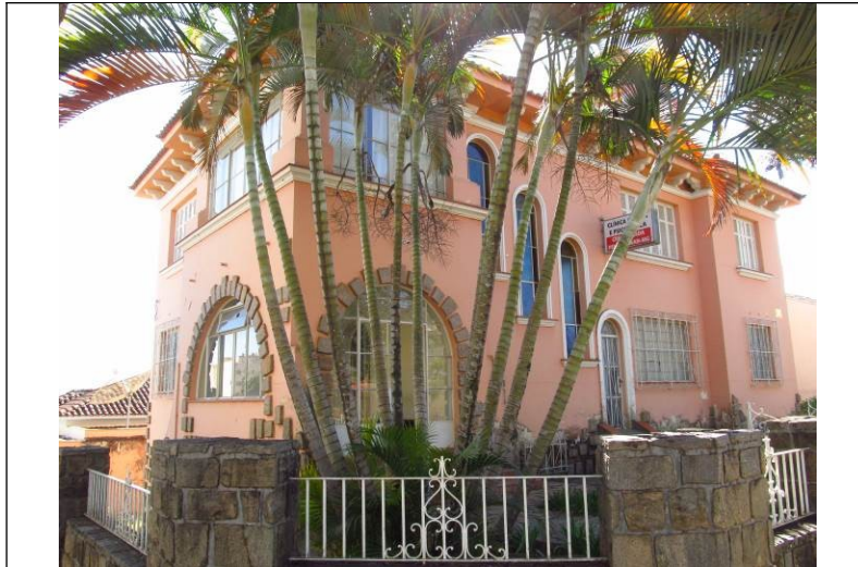
Figura 52 – Fachada frontal do imóvel.
