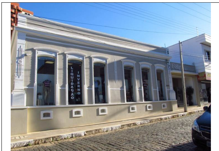
Figura 18 – Fachada frontal do imóvel.
