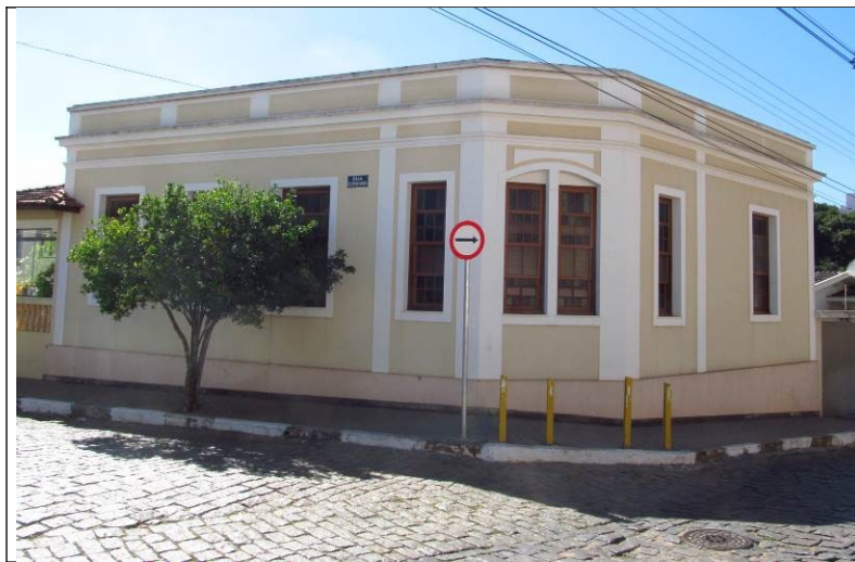
Figura 71– Fachada frontal do imóvel.
