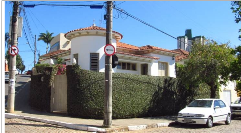
Figura 70– Fachada frontal do imóvel.
