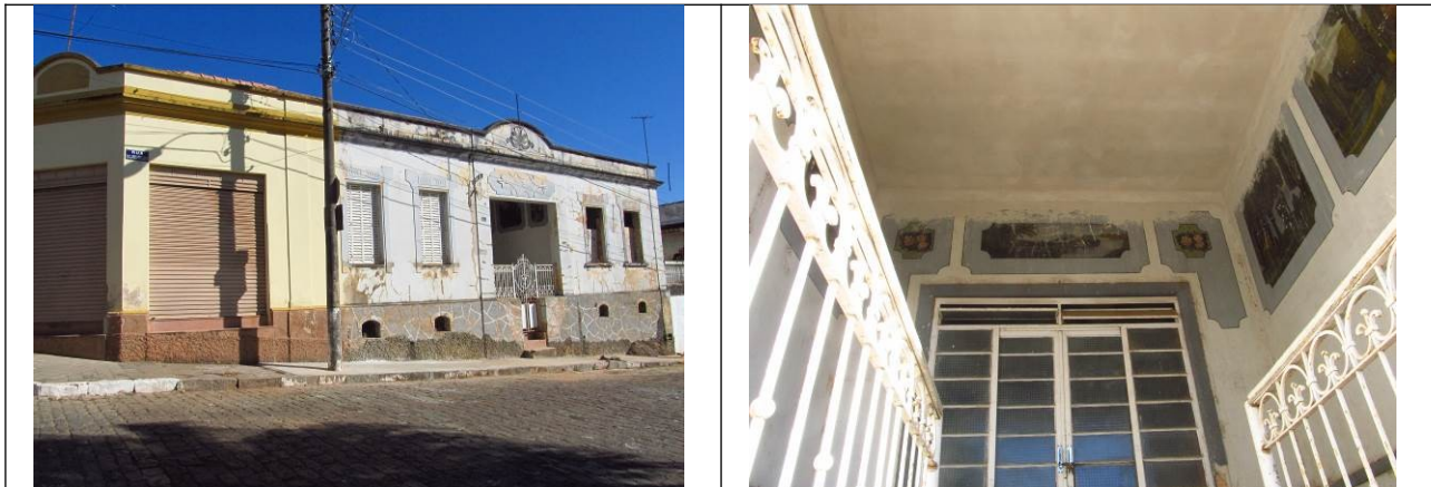
Figuras 03 e 04 – Fachada frontal do imóvel e detalhes das pinturas inseridas em sua entrada.
