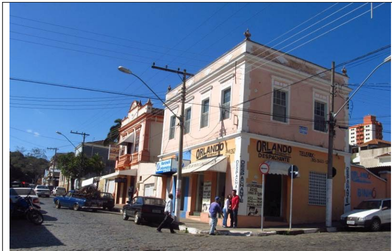
Figura 65 – Fachada frontal e lateral do imóvel.
