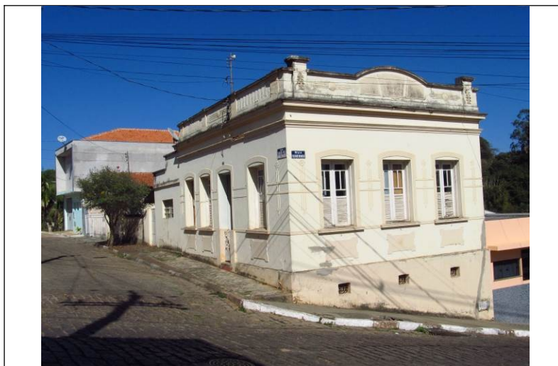
Figura 56 – Fachada frontal e lateral do imóvel.
