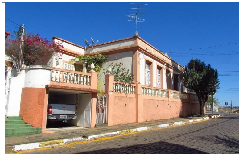
Figura 76– Fachada frontal do imóvel.
