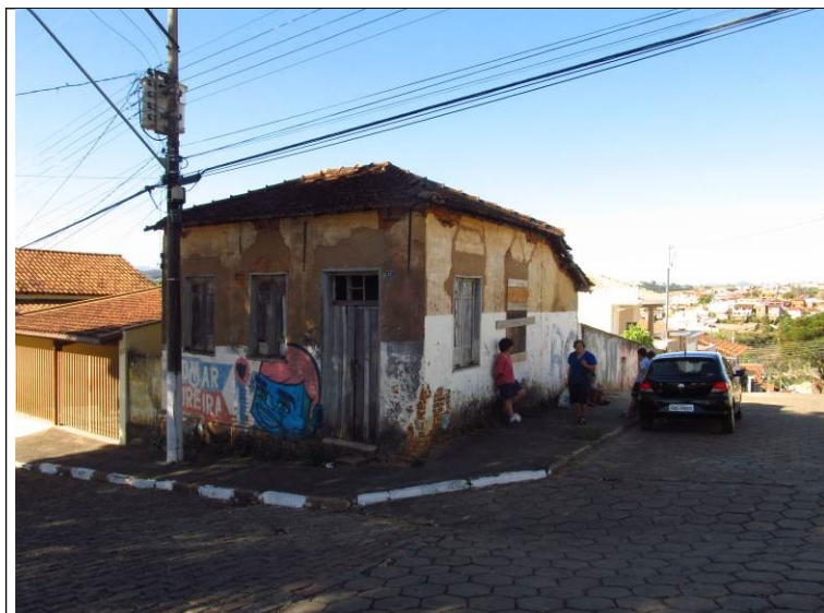
Figura 08 – Fachada frontal do imóvel.
