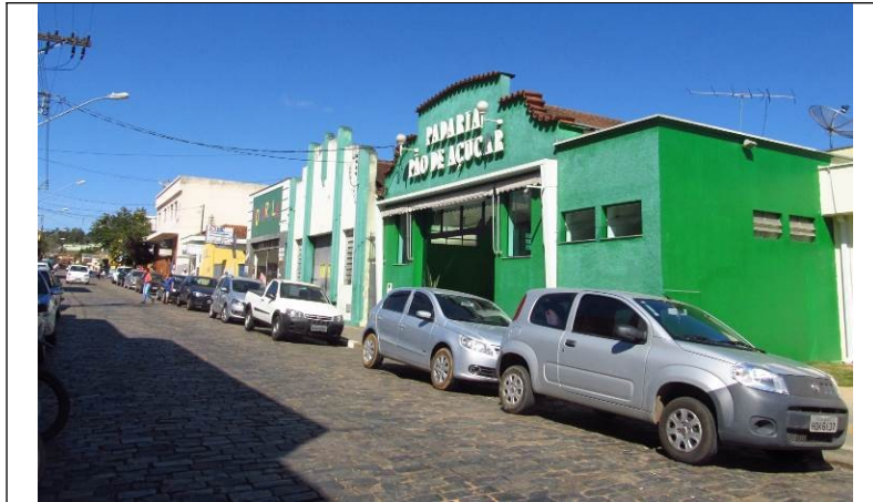
Figura 68– Fachada frontal do imóvel.
