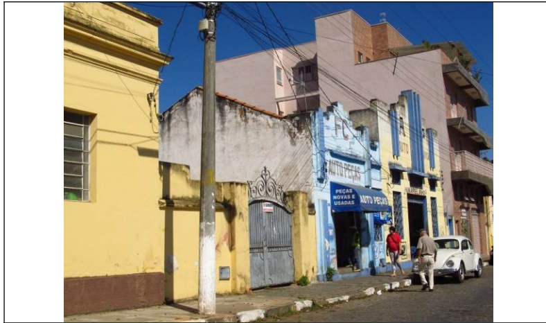
Figura 40 – Fachada frontal do imóvel.
