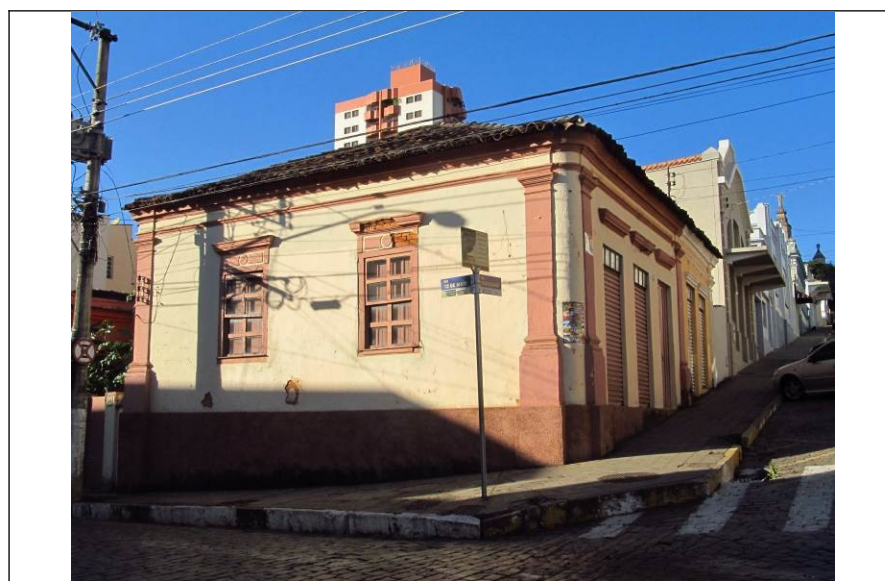
Figura 27 – Fachada frontal do imóvel.
