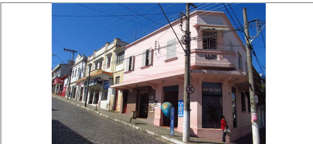
Figura 29 – Fachada frontal e lateral do imóvel.
