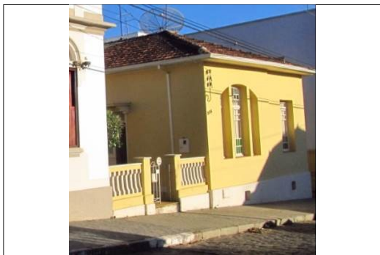
Figura 24 – Fachada frontal do imóvel.
