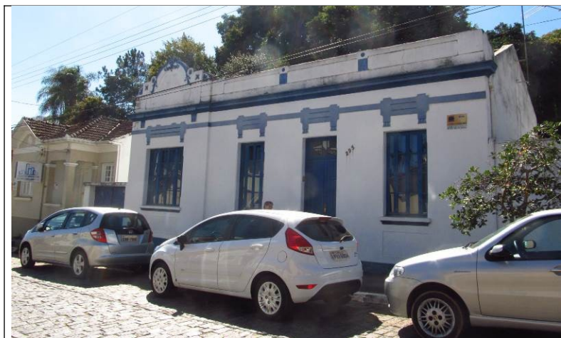
Figura 69– Fachada frontal do imóvel.
