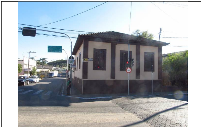
Figura 37 – Fachada frontal do galpão.
