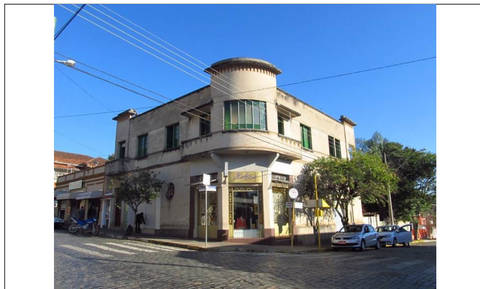
Figura 31 – Fachada frontal do imóvel.
