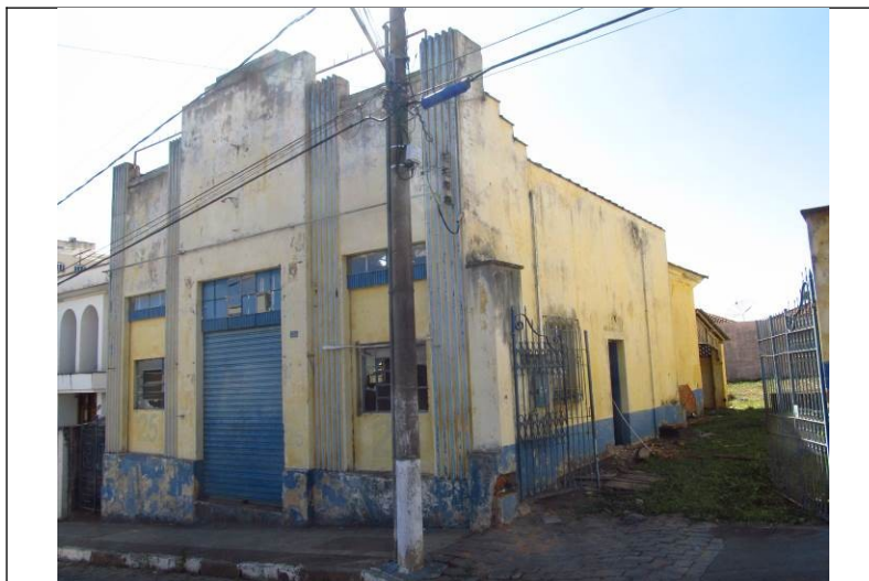
Figura 60 – Fachada frontal e lateral do imóvel.
