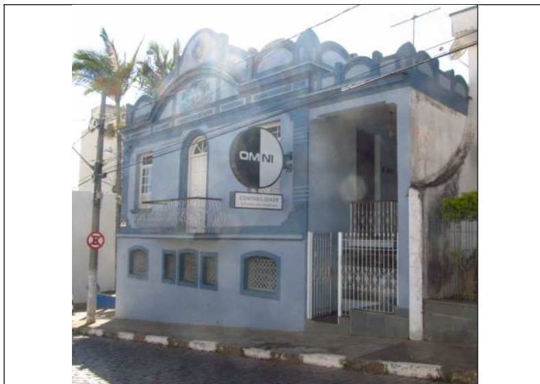
Figura 62 – Fachada frontal do imóvel.
