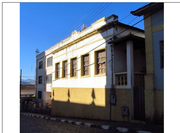
Figura 10 – Fachada frontal do imóvel.
