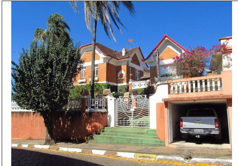
Figura 75– Fachada frontal do imóvel.
