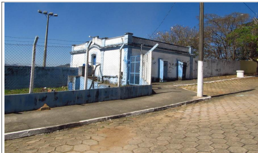
Figura 81– Fachada frontal do imóvel.
