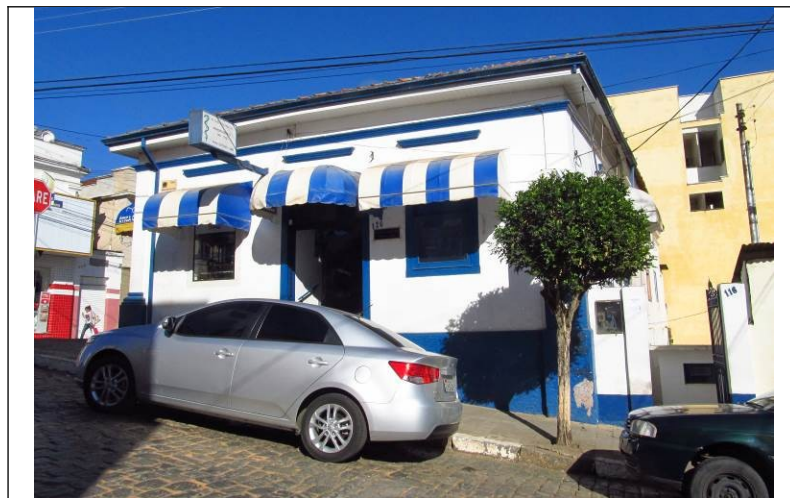
Figura 45 – Fachada frontal do imóvel.
