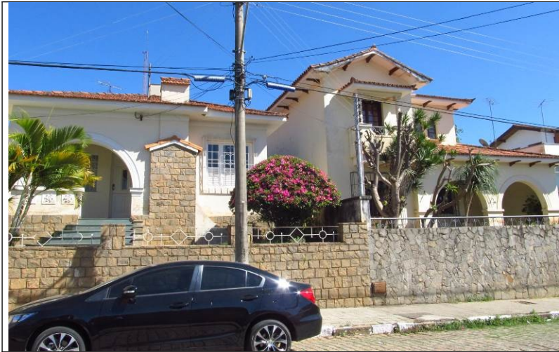
Figura 77– Fachada frontal do imóvel.
