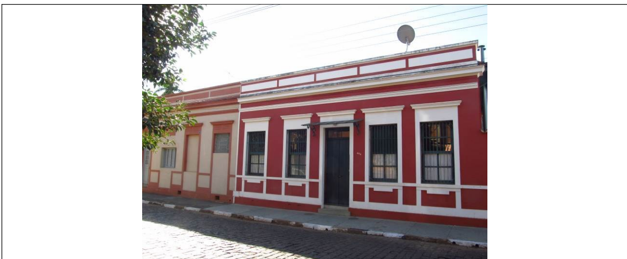
Figura 11– Fachada frontal do imóvel.
