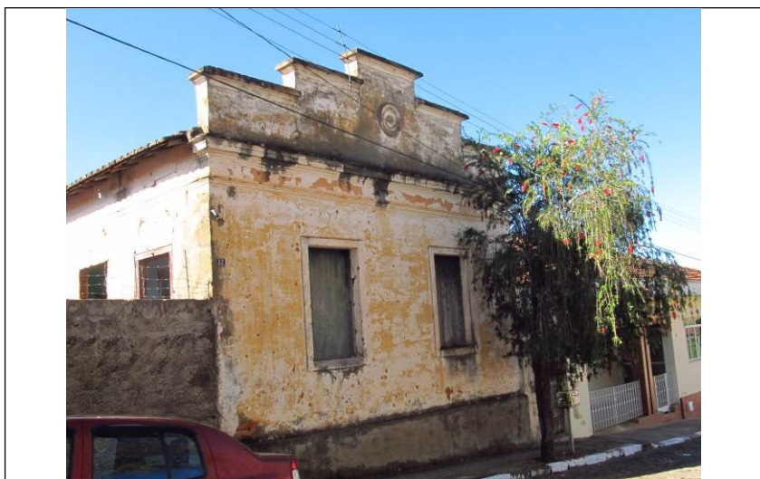
Figura 07 – Fachada frontal do imóvel.
