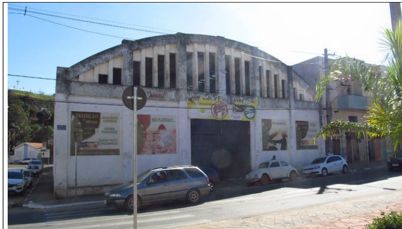
Figura 36 – Fachada frontal do galpão.
