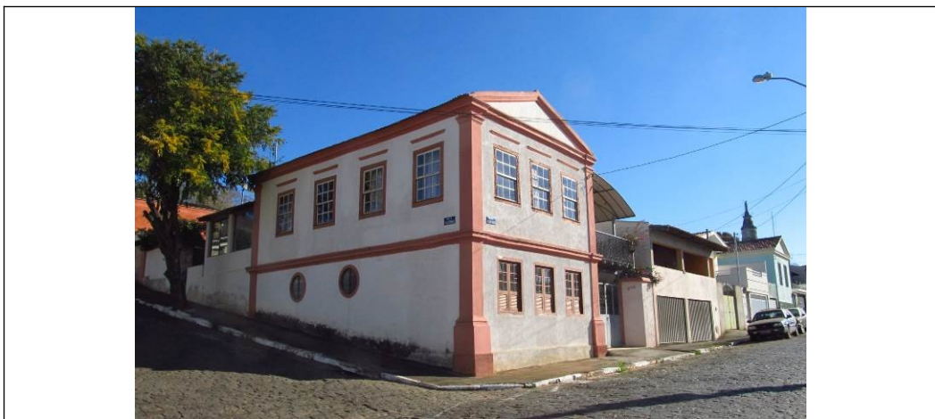
Figura 14 – Fachada frontal e lateral do imóvel.
