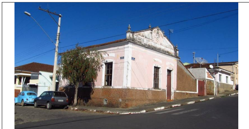
Figura 06 – Fachada frontal do imóvel.
