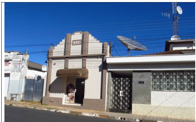
Figura 05 – Fachada frontal do imóvel.
