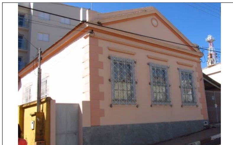
Figura 58 – Fachada frontal do imóvel.
