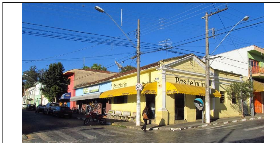
Figura 30 – Fachada frontal e lateral do imóvel.
