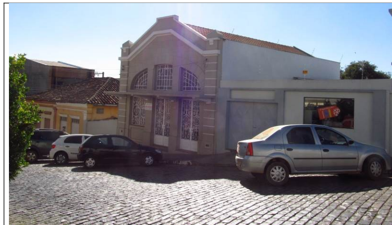
Figura 49 – Fachada frontal do imóvel.
