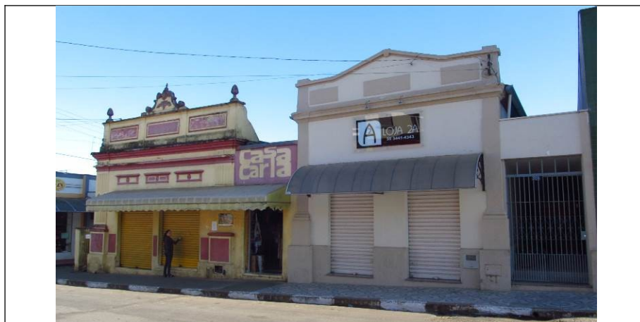
Figura 33 – Fachadas frontais dos imóveis.
