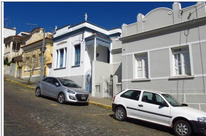
Figura 64 – Fachadas frontais dos imóveis.
