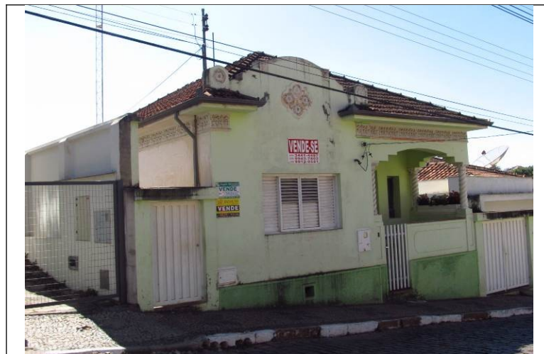
Figura 74– Fachada frontal do imóvel.
