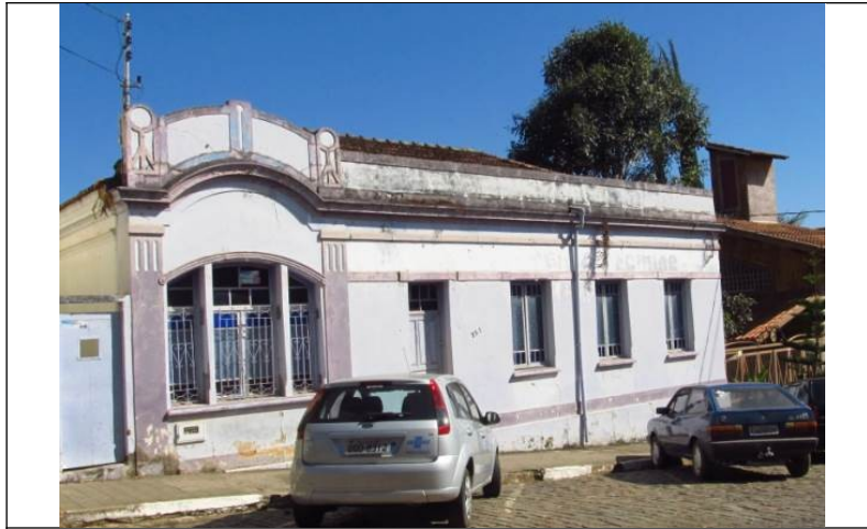
Figura 59 – Fachada frontal e lateral do imóvel.
