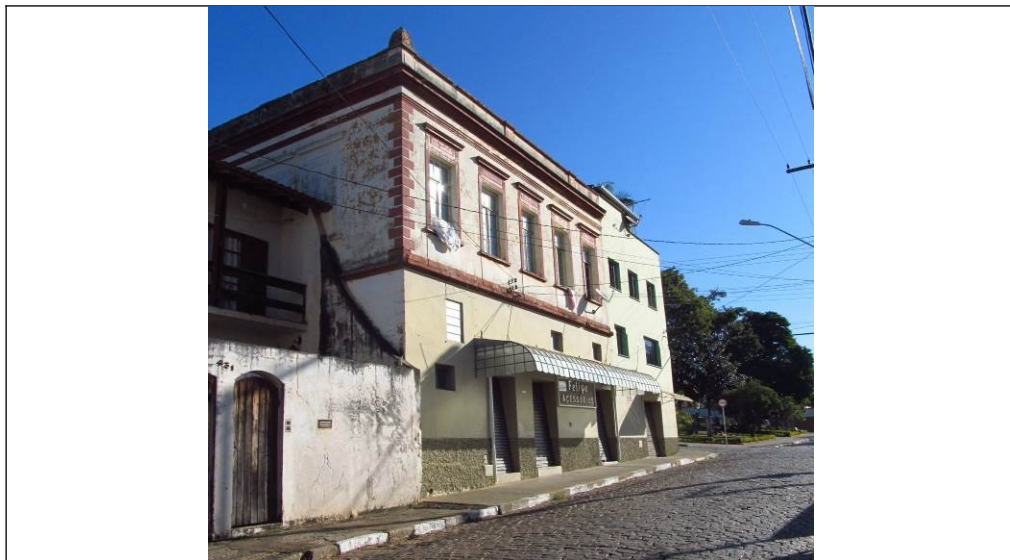
Figura 15 – Fachada frontal do imóvel.
