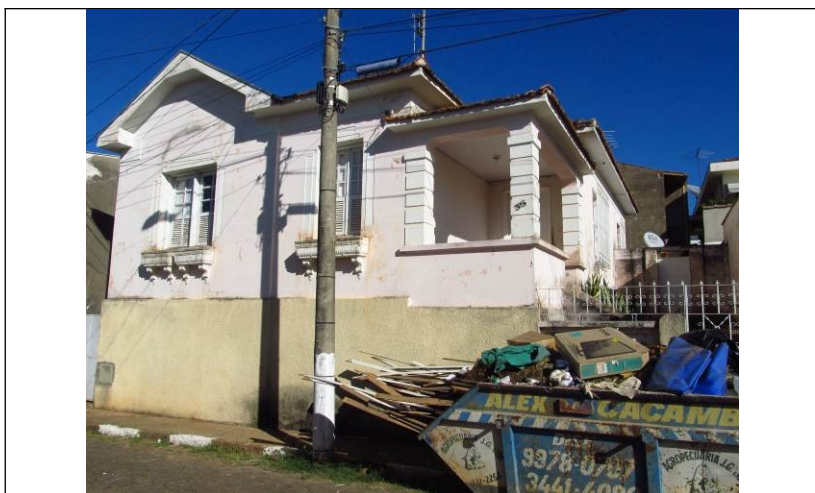
Figura 09 – Fachada frontal do imóvel.
