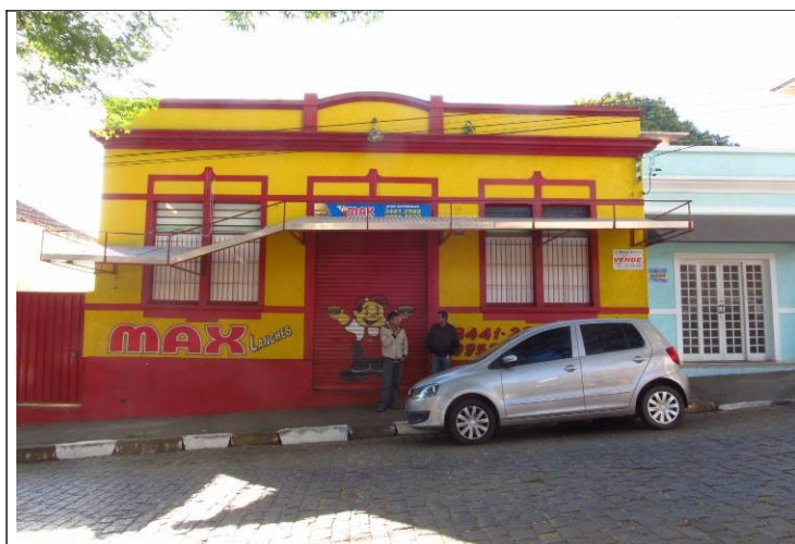
Figura 35 – Fachada frontal dos imóvel.
