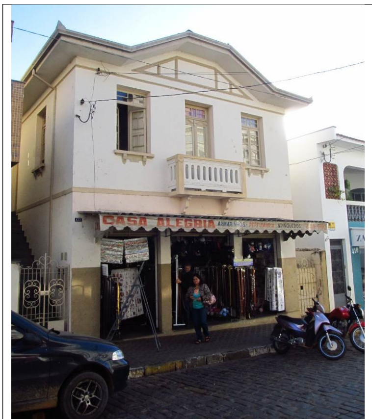
Figura 25 – Fachada frontal do imóvel.
