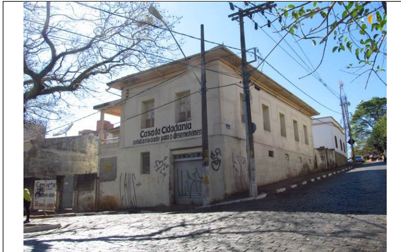
Figura 55 – Fachada frontal e lateral do imóvel.
