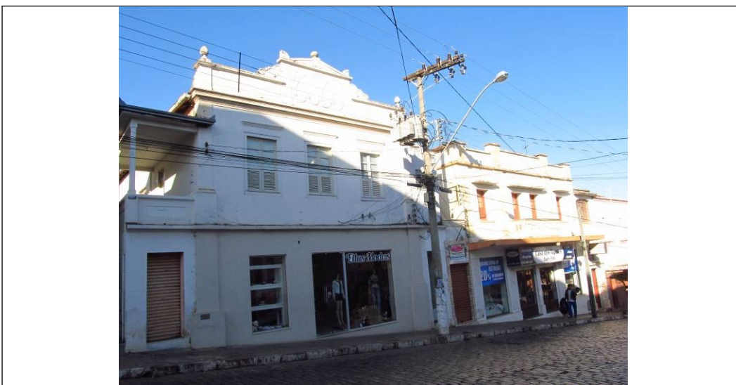
Figura 28 – Fachadas frontais do imóveis.
