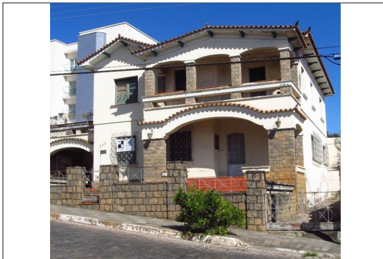
Figura 51 – Fachada frontal do imóvel.
