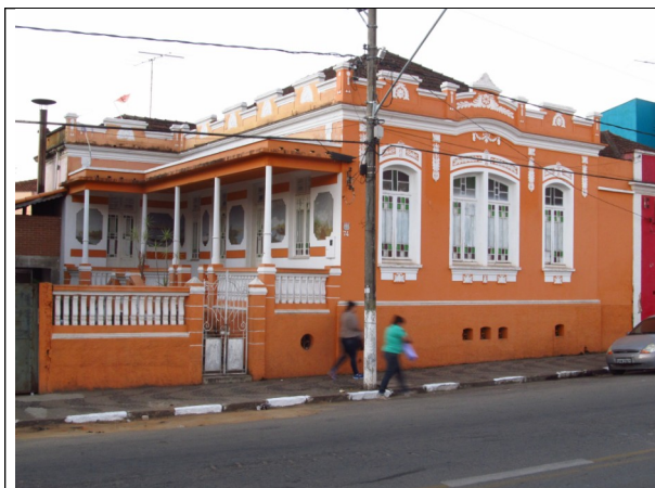
Figura 06 – Fachada frontal do imóvel.
