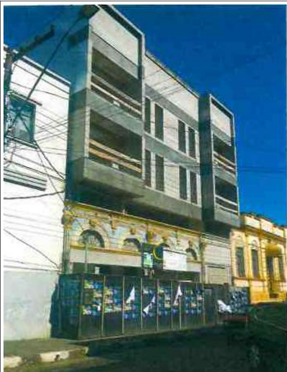
Figura 06 - Estágio atual da obra.
