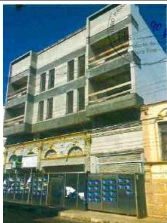
Figura 07 - Estágio atual da obra.
