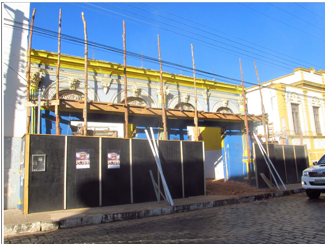
Figura 03 – Situação do imóvel na data da vistoria em 2015.
