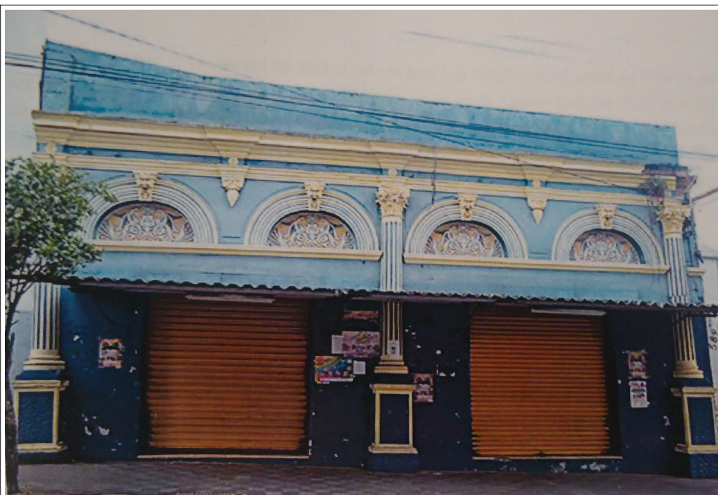
Figura 02 - Fachada do imóvel em 2014
