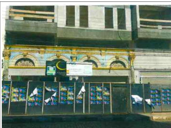
Figura 05 - Estágio atual da obra.
