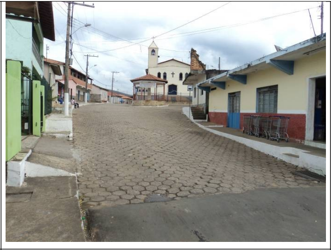
Figura 14 – Rua Principal. Transição entre a pavimentação asfáltica e o piso intertravado.
