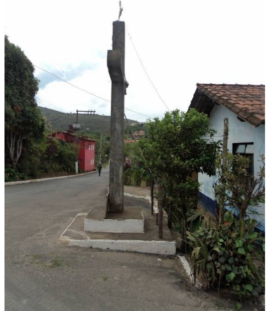
Figura 04 - Cruzeiro no entroncamento entre as Ruas Principal, Santa Efigênia e da Linha. Situação em 2013.
