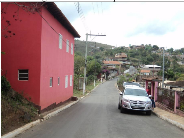
Figura 11 - Rua de Baixo com pavimentação asfáltica em 2013.
