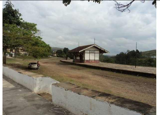
Figura 08 – Rua Principal em 2013 com passeio cimentado, sem aprovação.
