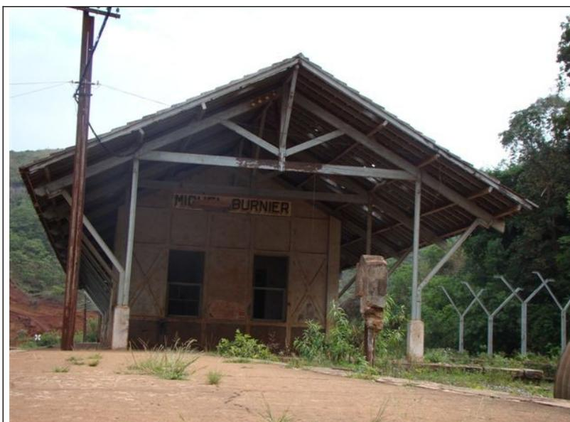
Figura 12 – Fissuras e plantas invasoras no piso da plataforma.
