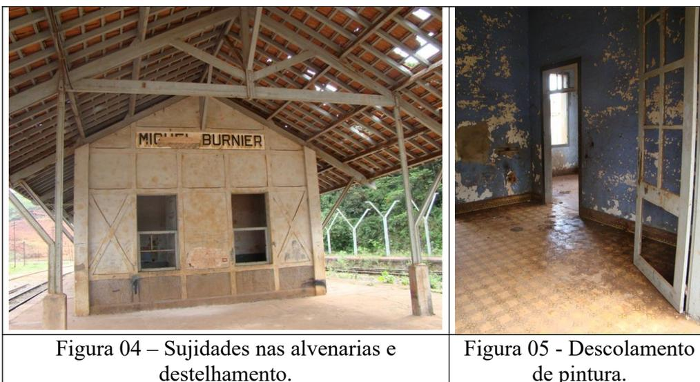
Figura 04 – Sujidades nas alvenarias e destelhamento.
